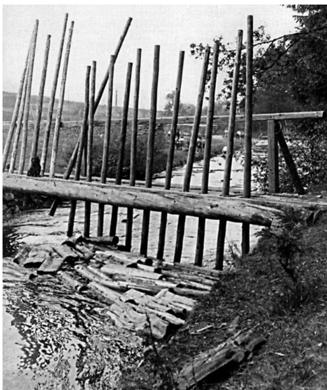
↑ Fig. 15. A simple barrier consisting of piers in the form of piles (a) driven into the riverbed, supports on the downstream side (b) propped against short piles (c), girders made from spruce or larch beams (d) with drilled-in oblique openings for inserting the bars of the bar screen (e) braced between two thinner ground sill beams at the riverbed (f), source: ECKERT, Franz – LORENZ, Heinrich, Lehrbuch der Forstwirtschaft für Waldbau- und Försterschulen sowie zum forstlichen Unterrichte für Aspiranten des Forstverwaltungsdienstes. III. Band. Die forstlichen Fachgegenstände , Wien 1903, p. 324, redrawn by Veronika Babická
