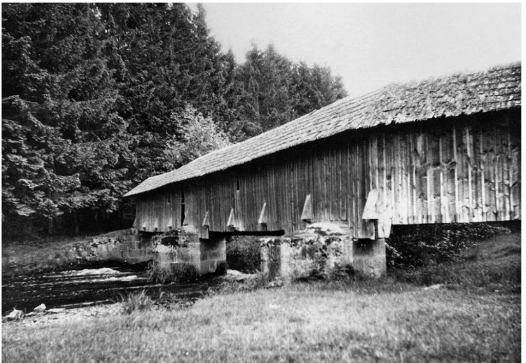
Fig. 7. Blansko near Kaplice, the Ponholz barrier, rear view, photo: V. Šolc, 1955, source: Etnologický ústav AV ČR, v.v.i., photo documentation collection Prague, sign. 5957a HK
