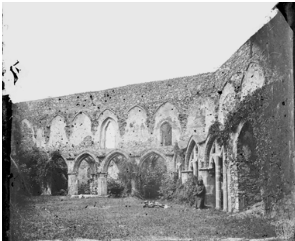
Obr. 4. Zvíkov, hrad, pohled na severní a severovýchodní stranu nádvoří paláce, zdroj: AHMP, Sběrka fotografií, sign. XII 340, foto: Jindřich Eckert, mezi 1876–1878
