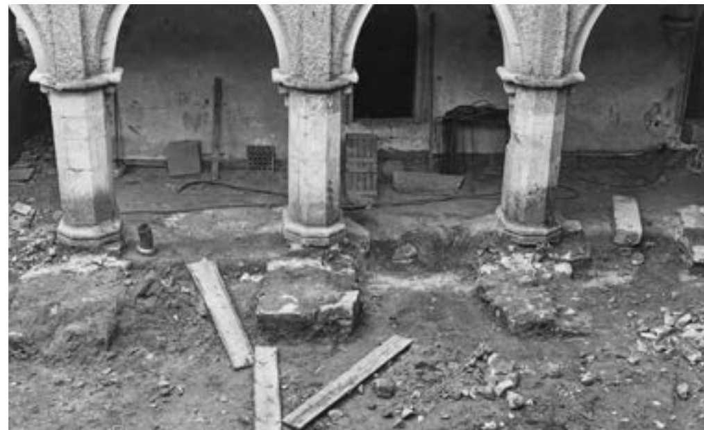
Obr. 8. Zvíkov, hrad, odkryté základy opěráků západního ramene ochozu paláce, zdroj: LÍBAL, Dobroslav – LIŠKOVÁ, Alena, Hrad Zvíkov. Stavebně historický průzkum Královského paláce. Dílčí zhodnocení nálezu vnitřního nádvoří , Praha 1977, příloha 2, NPÚ GnŘ, bez inv. č.
