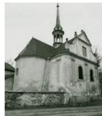
Obr. 14. Vyšší Brod, špitální kaple sv. Josefa (původně sv. Alžběty), pohled od severovýchodu, foto 1988, zdroj: NPÚ, ÚOP v Českých Budějovicích, složka s evidenčním listem památky
