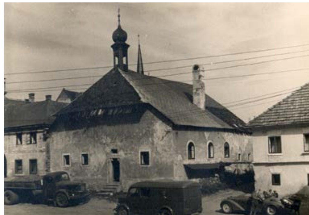
Obr. 15. Vyšší Brod, městský špitál se zvoničkou nad vstupním průčelím, pohled z náměstí od jihozápadu, říjen 1956, zdroj: NPÚ, ÚOP v Českých Budějovicích, plánový archiv, sign. č. 799, Jan Holín, Vyšší Brod, městský špitál čp. 46 – dokumentace 1 : 50
