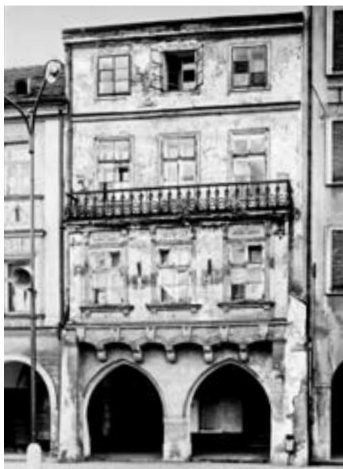
Obr. 3. České Budějovice, Žižkovo náměstí, nyní náměstí Přemysla Otakara II. čp. 34, průčelí zde-vastovaného domu zvaného Spitzerovina, zdroj: NPÚ, ÚOP v Českých Budějovicích, foto: Karel Krejčí, 1962
