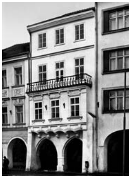
Obr. 4. České Budějovice, Žižkovo náměstí, nyní náměstí Přemysla Otakara II. čp. 34, průčelí domu zvaného Spitzerovina v průběhu obnovy, zdroj: NPÚ, ÚOP v Českých Budějovicích, foto: Jihočeský podnik pro údržbu památek Tábor, P. Špandl, před 1968
