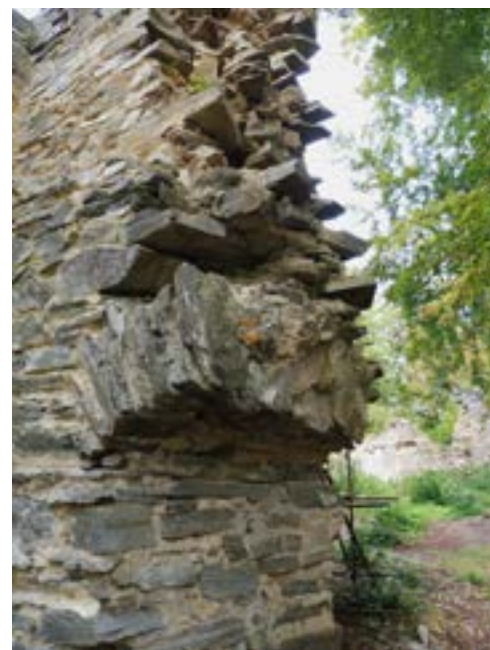
Obr. 8. Karlův Hrádek u Purkarce, úsek stěny č. 27 (resp. 29), stav před zahájením konzervačních a zajišťovacích prací a zajištěním převisu pozůstatku okenního záklenku (III. etapa), foto: autor, 2021
