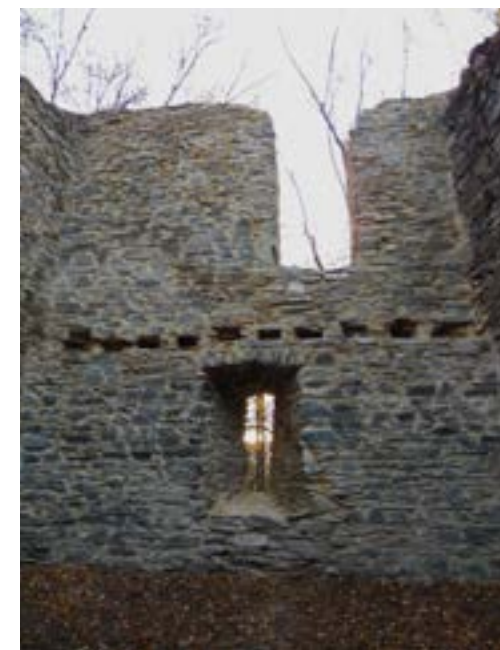
Obr. 9. Karlův Hrádek u Purkarce, úsek stěny č. 25, stav po dokončení konzervačních a zajišťovacích prací (III. etapa), foto: autor, 2021
