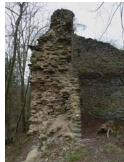
Obr. 4. Karlův Hrádek u Purkarce, úsek stěny č. 8, 9, stav před zahájením konzervačních a zajišťovacích prací (I. etapa), foto: autor, 2019
