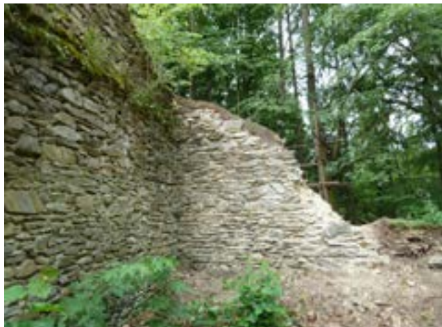
Obr. 6. Karlův Hrádek u Purkarce, úsek stěny č. 6a, 31, stav po dokončení konzervačních a zajišťovacích prací (I. etapa), foto: autor, 2019
