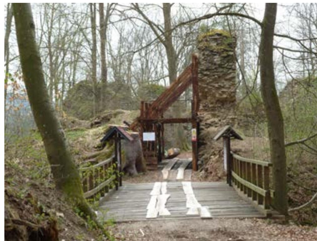
Obr. 2. Karlův Hrádek u Purkarce, provizorní zajištění havarijního stavu zdiva v místě vstupní brány, pohled od severu, foto: autor, 2019
