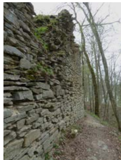
Obr. 3. Karlův Hrádek u Purkarce, úsek stěny č. 6a, 31, stav před zahájením konzervačních a zajišťovacích prací (I. etapa), foto: autor, 2019
