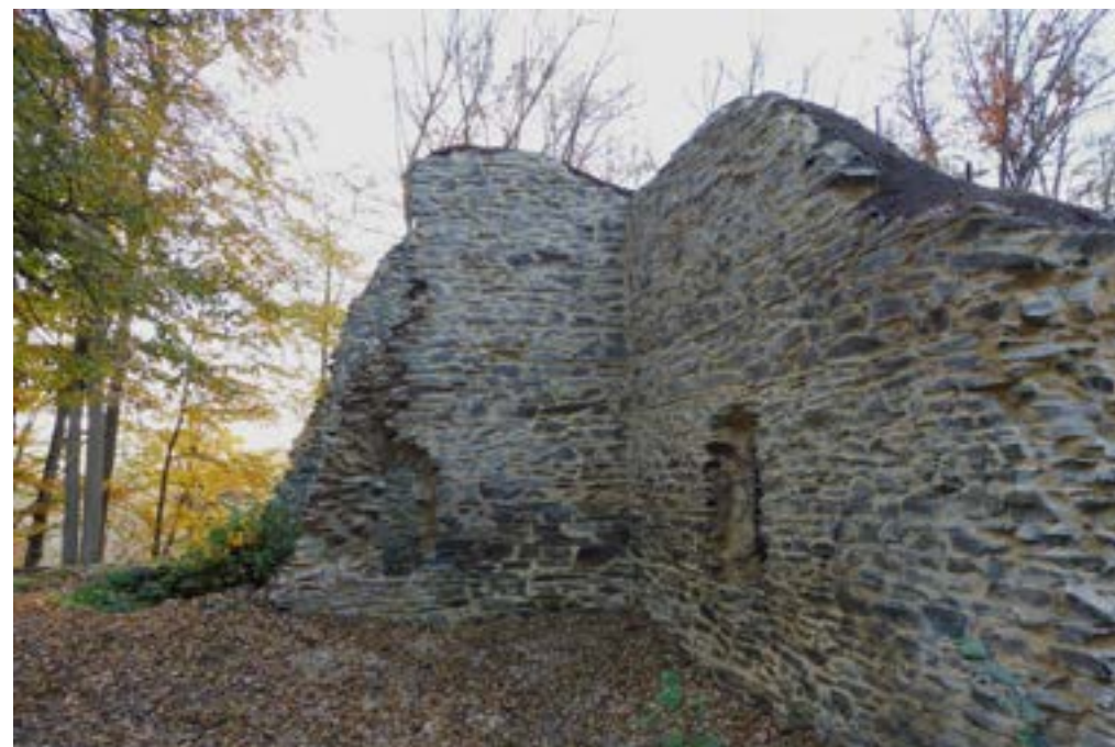
Obr. 7. Karlův Hrádek u Purkarce, úsek stěny č. 27, 28, stav po dokončení konzervačních a zajišťovacích prací a zajištění převisu pozůstatku okenního záklenku (III. etapa), foto: autor, 2021
