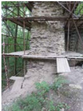
Obr. 5. Karlův Hrádek u Purkarce, úsek stěny č. 8, 9, stav po dokončení konzervačních a zajišťovacích prací (I. etapa), foto: autor, 2019
