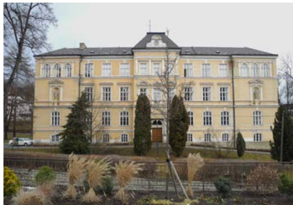
↑ Obr. 4. Vimperk, Pražská čp. 167, základní škola, uliční fasáda na počátku obnovy, foto: autor, 2017
