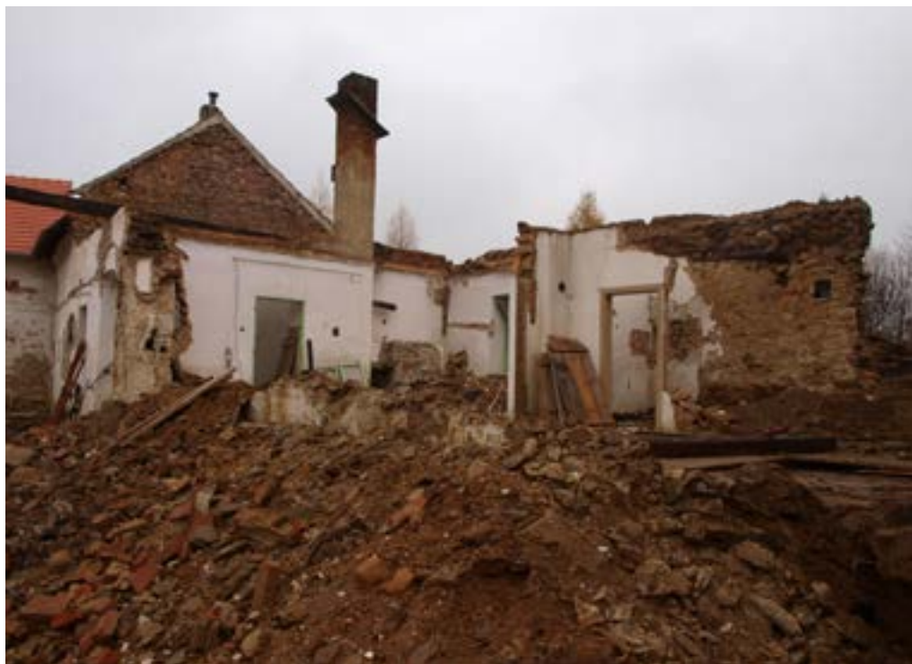
Obr. 9. Mirkovice, zemědělská usedlost čp. 1, síňový dil a komorová část (v pozadí) během demoličních prací zděných konstrukcí po uložení roubení jizby v klatovském depozitáři Vlastivědného muzea Dr. Hostaše, zdroj: NPÚ, ÚOP v Českých Budějovicích, foto: Daniel Šnejd, listopad 2013
