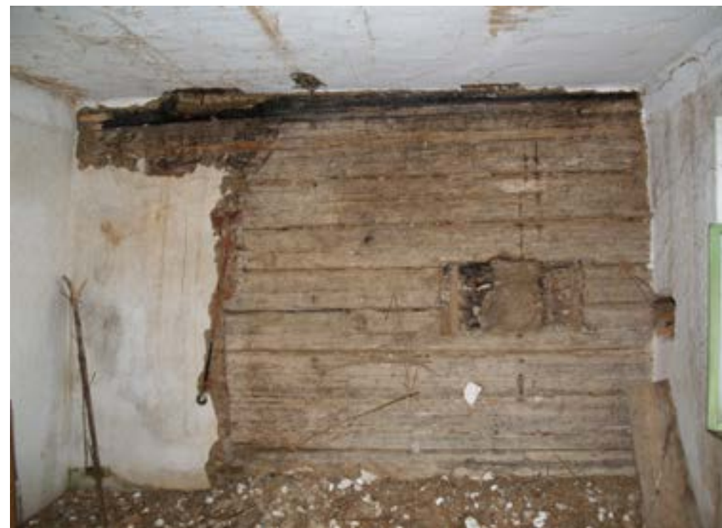
Obr. 8. Mirkovice, zemědělská usedlost čp. 1, částečně odryté roubení v interiéru světnice (bývalé jizby) během průzkumových prací, zdroj: NPÚ, ÚOP v Českých Budějovicích, foto: Jakub Drozda, červen 2013
