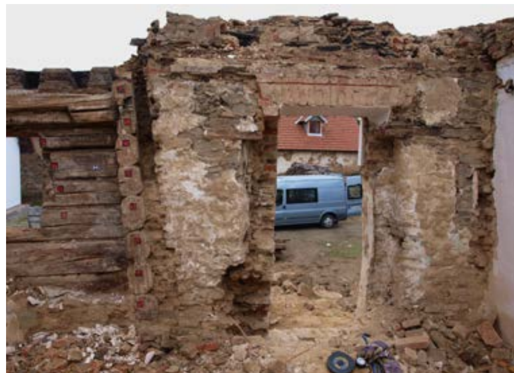
↑ Obr. 5. Mirkovice, zemědělská usedlost čp. 1, odříznutá zhlaví trámů příčky oddělující jizbu od síně, doklad nekompletního dochování středověkých konstrukcí, vpravo původní vstup do domu, zvýšené nadpraží při mladším okenním otvoru, foto: Daniel Šnejd, 2013
