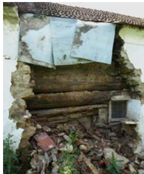
↑ Obr. 5. Mirkovice, zemědělská usedlost čp. 1, odříznutá zhlaví trámů příčky oddělující jizbu od síně, doklad nekompletního dochování středověkých konstrukcí, vpravo původní vstup do domu, zvýšené nadpraží při mladším okenním otvoru, foto: Daniel Šnejd, 2013
