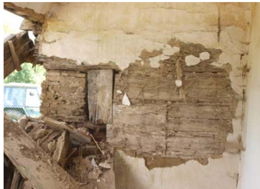
Obr. 7. Mirkovice, zemědělská usedlost čp. 1, havárie roubení při severovýchodním nároží zachycená v době před rozebíráním objektu, foto: Daniel Šnejd, 2013
