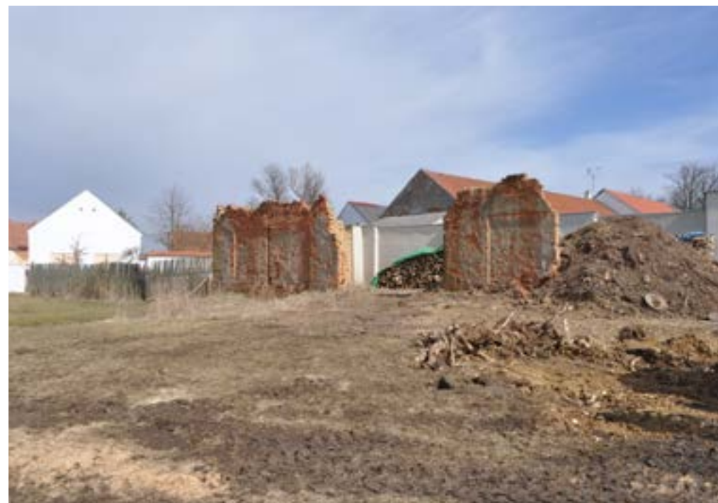
Obr. 1. Zálší, venkovská usedlost čp. 5, relikv stodoly, stav po vykácení náletových dřevin, foto: David Javorský, 2018
