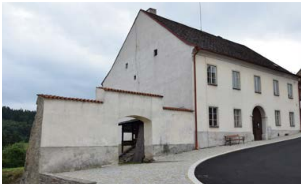
Obr. 18. Hořice na Šumavě, fara čp. 2, severní průčelí, foto: Zdeňka Kočková, 2021
