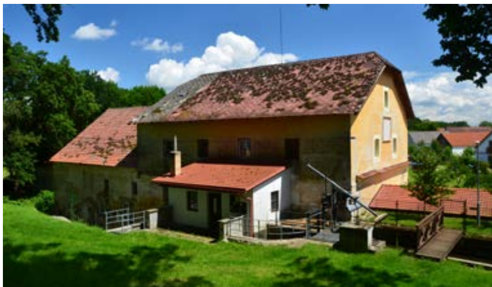
Obr. 22. Záblatí u Ponědraže, Valentův mlýn čp. 24, pohled od náhonu, foto: Jakub Drozda, 2020
