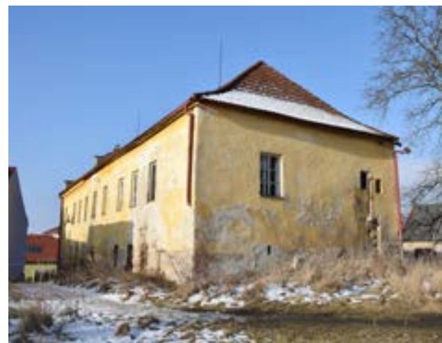
Obr. 17. Trhové Sviny, fara čp. 166 a 363, pohled od jihovýchodu, foto: Zdeňka Kočková, 2020
