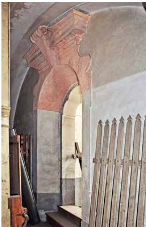
Obr. 12. Radošov, kostel sv. Václava, původní okno osvětlující kruchtu v jižním štítovém průčelí z interiéru
