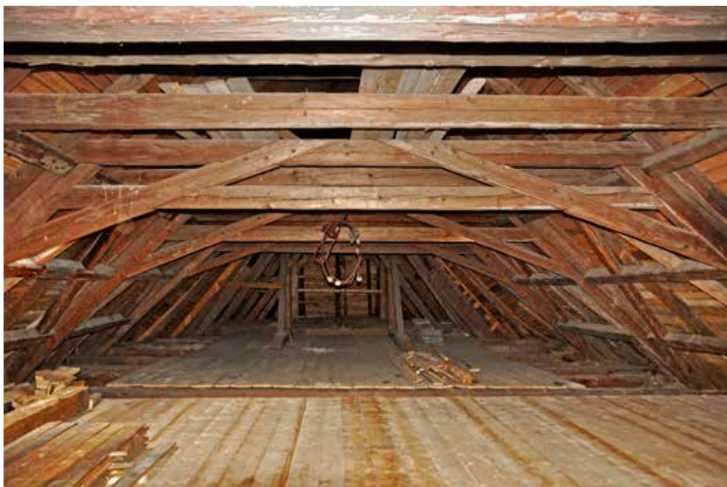
Obr. 19. Radošov, kostel sv. Václava, krov nad lodí, pohled směrem k závěru, kde je viditelný pozůstatek původní konstrukce sanktusové věže
