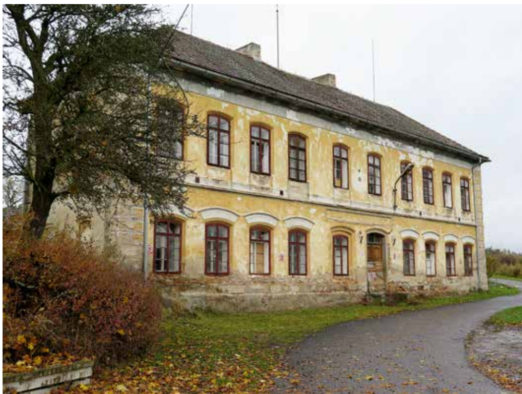
Obr. 8. Těchonice (okr. Klatovy), bývalá škola, celkový pohled na budovu od jihu, zdroj: Fotoarchiv NPÚ, územní odborné pracoviště v Plzni, foto: autor, 2020
