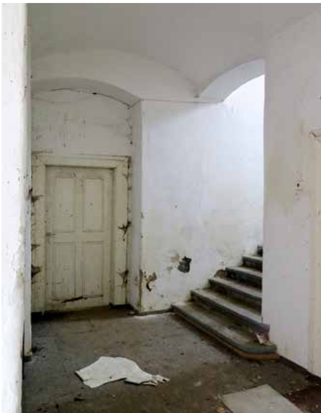
Obr. 9. Těchonice, bývalá škola čp. 13, pohled ke schodišti v přízemí, zdroj: Fotoarchiv NPÚ, územní odborné pracoviště v Plzni, foto: autor, 2020
