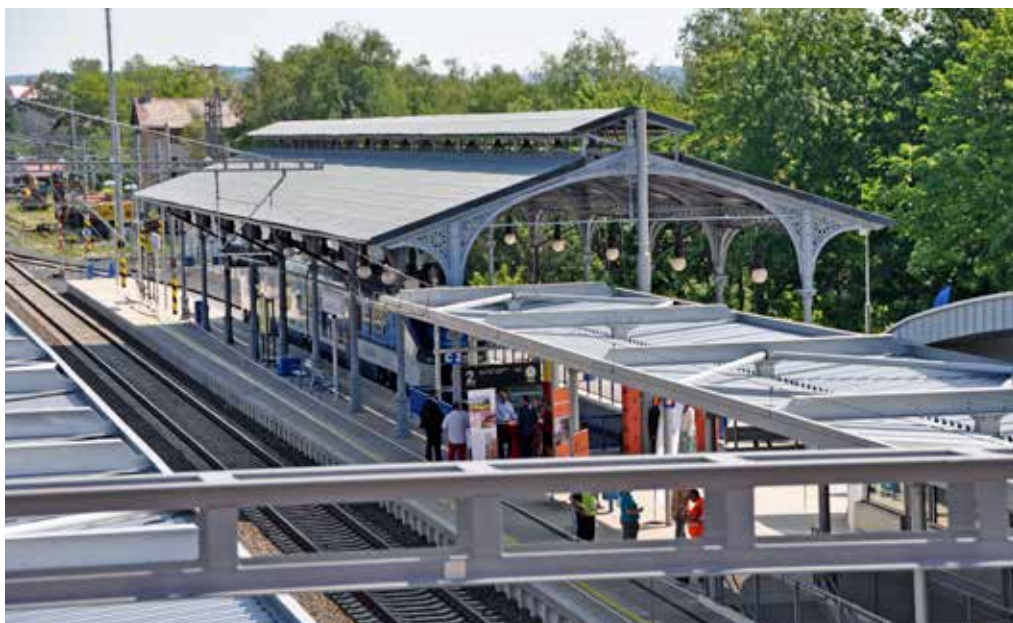
Obr. 3. Karlovy Vary, horní nádraží, litinový přístřešek po obnově nad kusou kolejí, foto: autor, 2019
