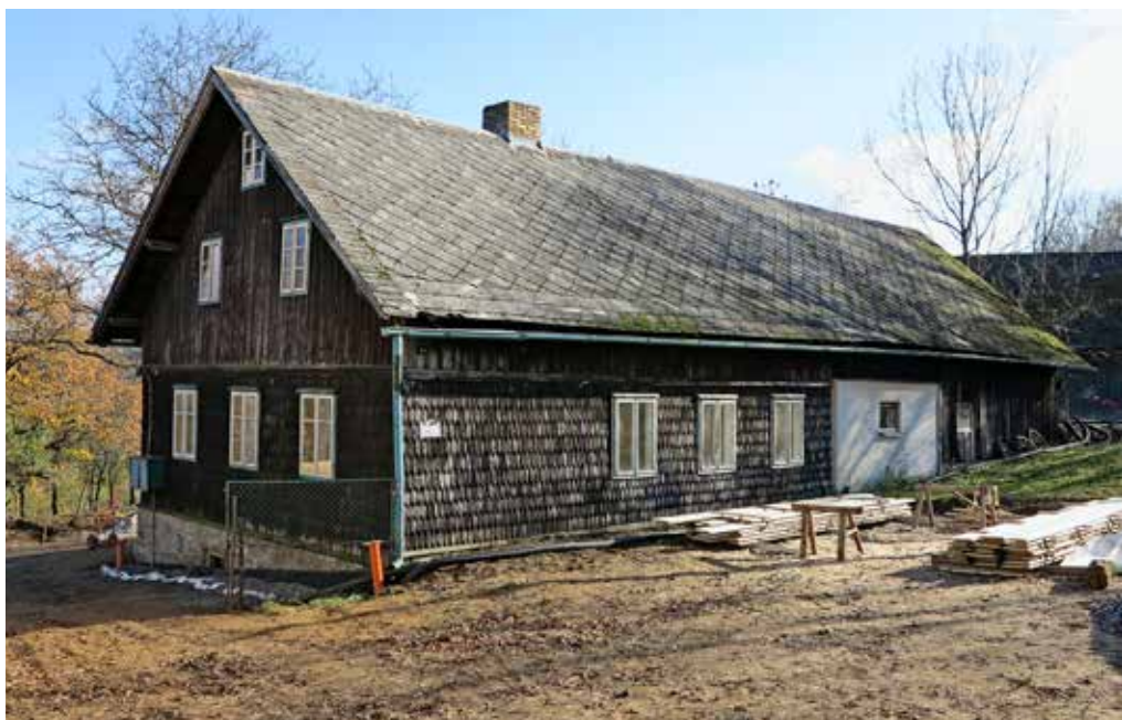
Obr. 5. Splž (Strážov, okr. Klatovy), venkovský dům čp. 6, pohled od severozápadu, zdroj: Národní památkový ústav, územní odborné pracoviště v Plzni, foto: autorka, 2020
