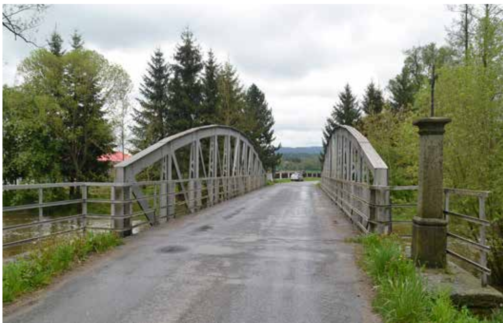
Obr. 4. Rohozno (Janovice nad Úhlavou, okr. Klatovy), silniční most s pamětním křížem, pohled od jihovýchodu, zdroj: Národní památkový ústav, územní odborné pracoviště v Plzni, foto: Stanislav Plešmíd, 2021
