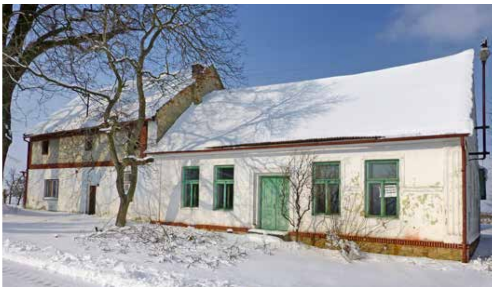
Obr. 6. Vysoká, zájezdni hostinec čp. 1, pohled na průčelí zájezdniho hostince, přízemní taneční sál postavený v roce 1912 a zadní část domu s roubeným patrem krytým eternitem, foto: Zuzana Vařeková, 2013
