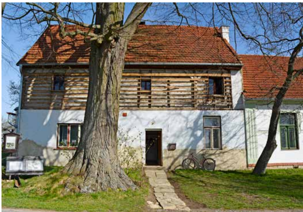
Obr. 8. Vysoká, čp. 1, pohled na jižní průčelí patrové části domu po sejmutí eternitového obkladu, přízemí je zděné z opuky a omítané, patro roubené, střeška vynášena obštávkou, foto: Zuzana Vařeková, jaro 2022
