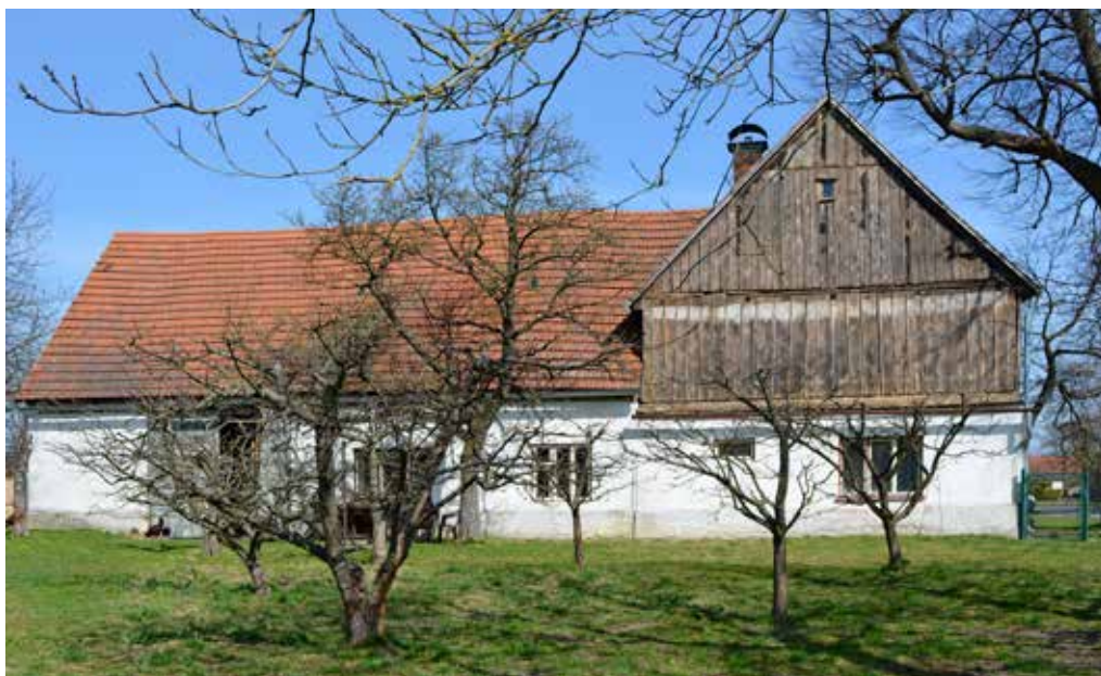
Obr. 9. Vysoká, čp. 1, pohled na západní průčelí usedlosti, patro a štít zachyceny po snesení eternitového obkladu, foto: Zuzana Vařeková, jaro 2022
