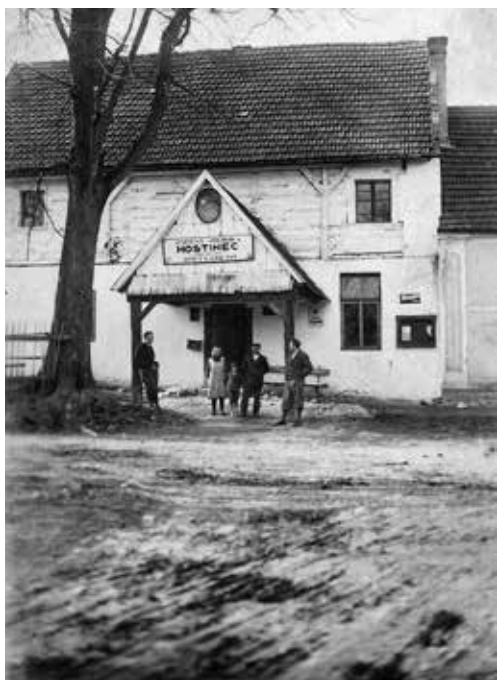
↑ Obr. 11. Vysoká, čp. 1, historická fotografie průčelí hostince před rokem 1911, před výstavbou secesního sálu, v přízemí domu v komorové části zachycena starší okenní výplň, průčelí doplněné dřevěnou otevřenou předsíní se sedlovou střechou a bedněným štítem s firemním poutačem, zdroj: Soukromá sbírka A. Blinky, Vysoká čp. 1
