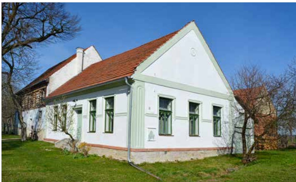
Obr. 7. Vysoká, zájezdní hostinec čp. 1, pohled na nároží secesního sálu po celkové obnově (oprava fasády, interiéru, přeložení střešní krytiny), foto: Zuzana Vařeková, 2022
