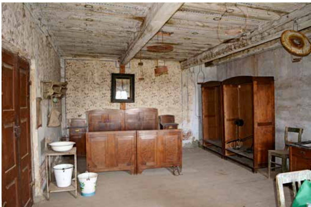
↑ Obr. 15. Vysoká, čp. 1, pohled do dochované části prostoru sálu v patře po demolicí zadního dílu domu v roce 1911/1912; místnost je uzavřená dřevěným stropem s okosenými trámy a záklopem ze širokých prken na sraz; hliněné omítky stěn jsou pojednány šablonovou výmalbou s barevným vegetabilním dekorem na světle zeleném podkladu, vyplňující pole, vymezená na způsob lizénových rámců tmavomodrou linkou, foto: Zuzana Vařeková, 2013
