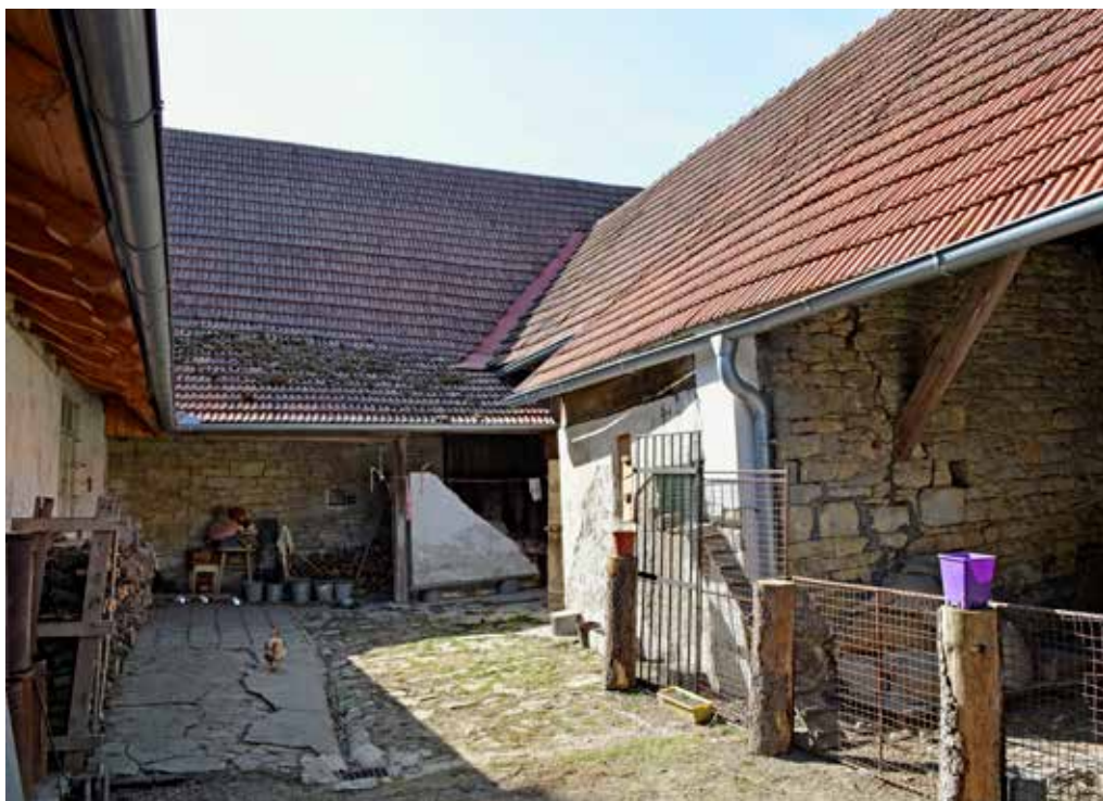
Obr. 18. Vysoká, čp. 1, pohled směrem do dvora usedlosti od brány; zleva objekt hostince a navazující veranda, vzadu opukové zdivo kolmého křídla stodoly s průjezdem do zahrady, před tím obílené těleso vstupu do „pivního“ sklepa, foto: Zuzana Vařeková, jaro 2022
