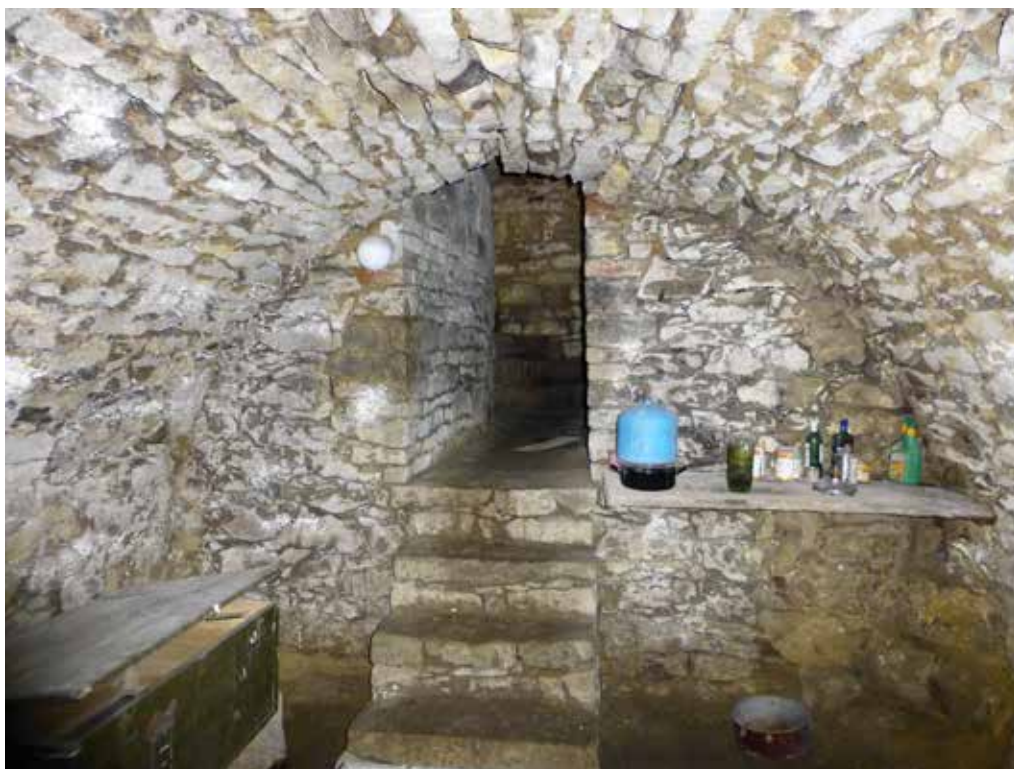
Obr. 19. Vysoká, čp. 1, pohled do prostoru sklepa situovaného pod secesním sálem; vstup do sklepa je druhotný, provedený v roce 1912, foto: Zuzana Vařeková, 2013
