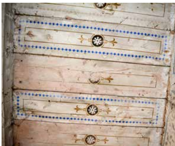
↑ Obr. 15. Vysoká, čp. 1, pohled do dochované části prostoru sálu v patře po demolicí zadního dílu domu v roce 1911/1912; místnost je uzavřená dřevěným stropem s okosenými trámy a záklopem ze širokých prken na sraz; hliněné omítky stěn jsou pojednány šablonovou výmalbou s barevným vegetabilním dekorem na světle zeleném podkladu, vyplňující pole, vymezená na způsob lizénových rámců tmavomodrou linkou, foto: Zuzana Vařeková, 2013
