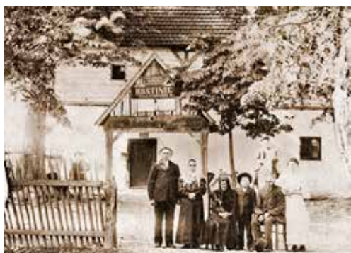
↑ Obr. 11. Vysoká, čp. 1, historická fotografie průčelí hostince před rokem 1911, před výstavbou secesního sálu, v přízemí domu v komorové části zachycena starší okenní výplň, průčelí doplněné dřevěnou otevřenou předsíní se sedlovou střechou a bedněným štítem s firemním poutačem, zdroj: Soukromá sbírka A. Blinky, Vysoká čp. 1
