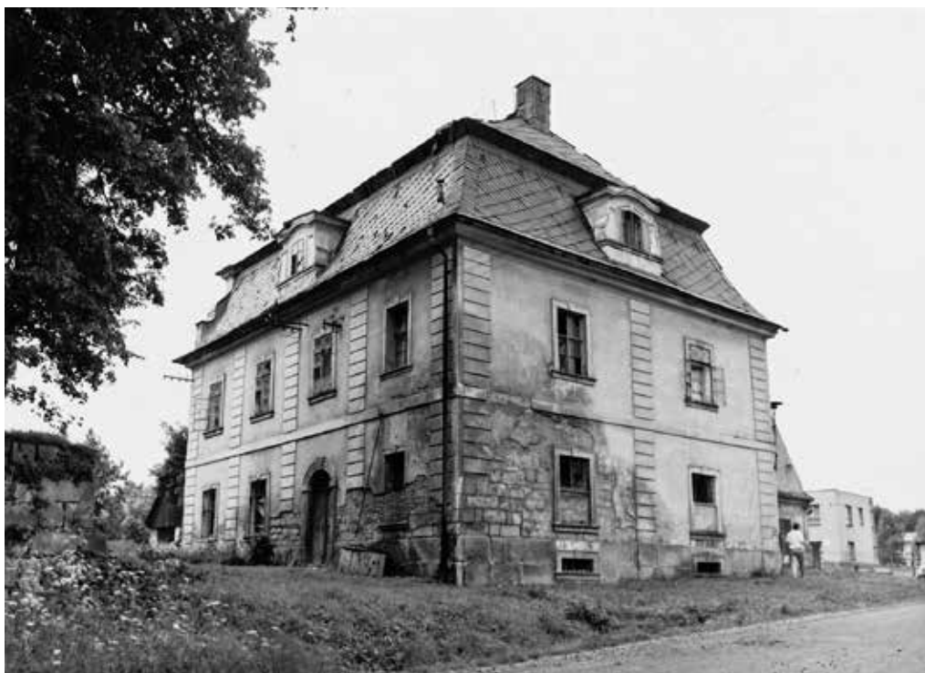
Obr. 8. Šonovská fara v roce 1988, pohled od severovýchodu, zdroj: fotoarchiv NPÚ, ÚOP v Josefově
