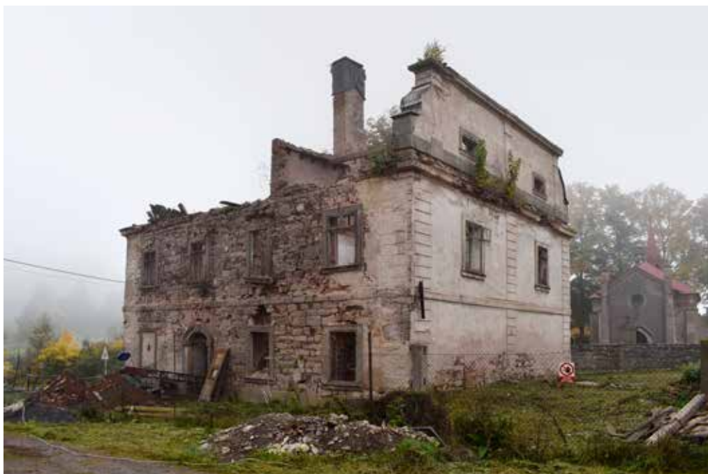
Obr. 13. Odklizení sutí z interiéru budovy, foto: Adam Zezula, 2022
