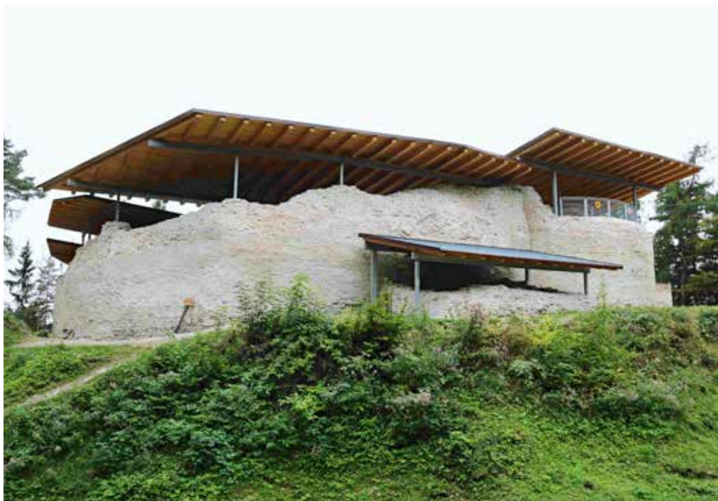
Obr. 5. Hrad Vizmburk, jádro hradu od severovýchodu s trvalým zastřešením, v popředí pultová střecha nad tzv. kovárnou, foto: autor, 2021
