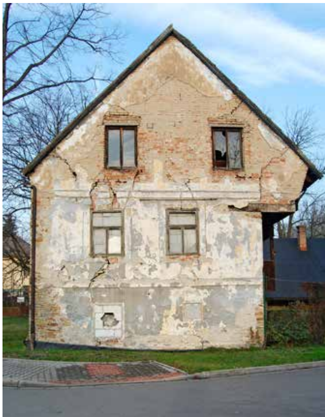
Obr. 1. České Meziříčí, Hrnčířův mlýn, hlavní štítové průčelí před opravou, foto: autor, 2017
