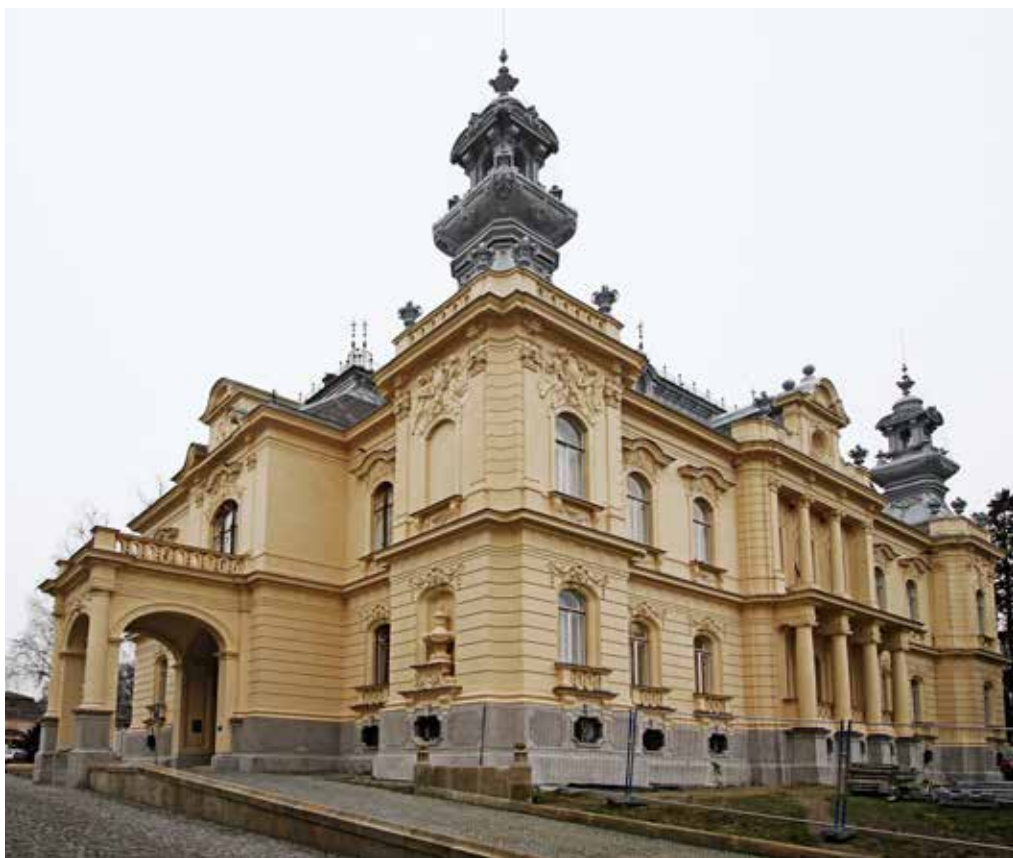
Obr. 1. Langerova vila po obnově, foto: Kateřina Profousová, 2021
