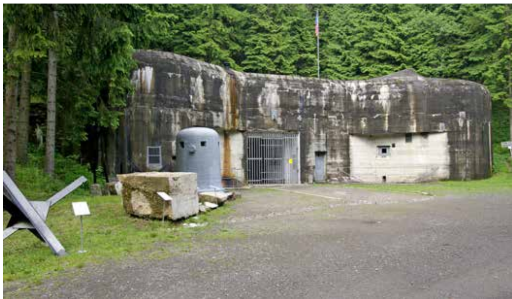
Obr. 1. Rekonstrukce vchodového objektu „Krok“ tvrze Bouda před obnovou, foto: Milan Křištof
