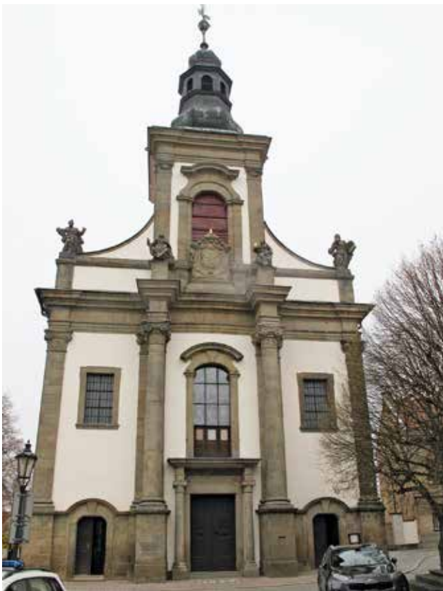
Obr. 3. Kostel Nanebevzetí Panny Marie v Ústí nad Orlicí po obnově, foto: Václav Paukrt, 2021
