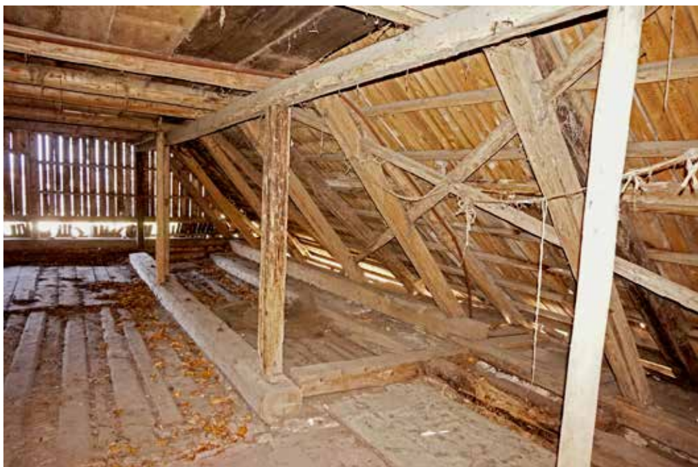
Obr. 13. Lichkov čp. 61 – pohled do krovu na podélnou stranu nad obytným dílem; příčně nevedou žádné trámy, foto: Petr Horák, 2021
