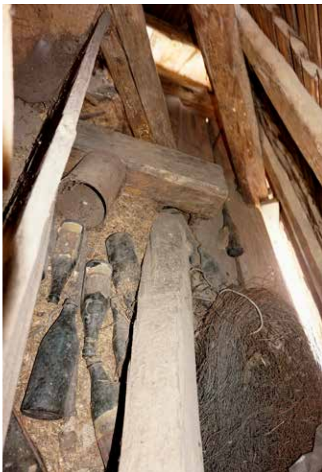
Obr. 1. Albrechtice čp. 47, pohled na konstrukční řešení, uprostřed odspoda nahoru prahová vaznice, foto: Petr Horák, 2021
