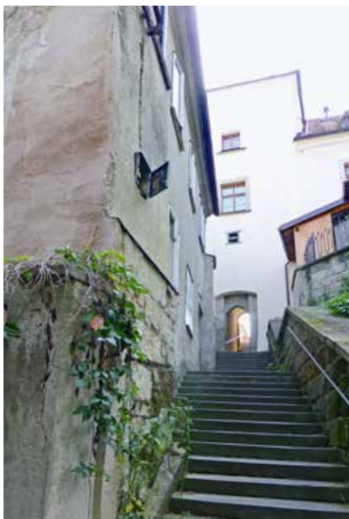
Obr. 6. Situace domu čp. 98/IV vlevo a Pardubské fortny, foto: Jitka Svobodová, 2020
