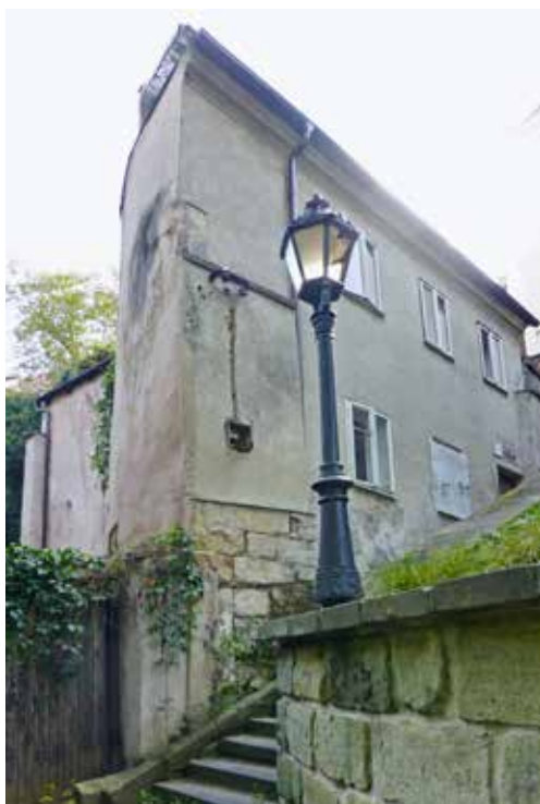
Obr. 5. Chrudim, dům čp. 98/IV, průčelí, pohled od severozápadu, foto: Jitka Svobodová, 2020
