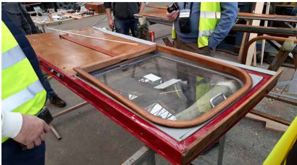
Obr. 16. Slovenská strela, restaurování vstupních dveří, nové dřevěné obložení, zdroj: RMK, fond Sbírka vlastivědného materiálu, foto: autorka, 2020
