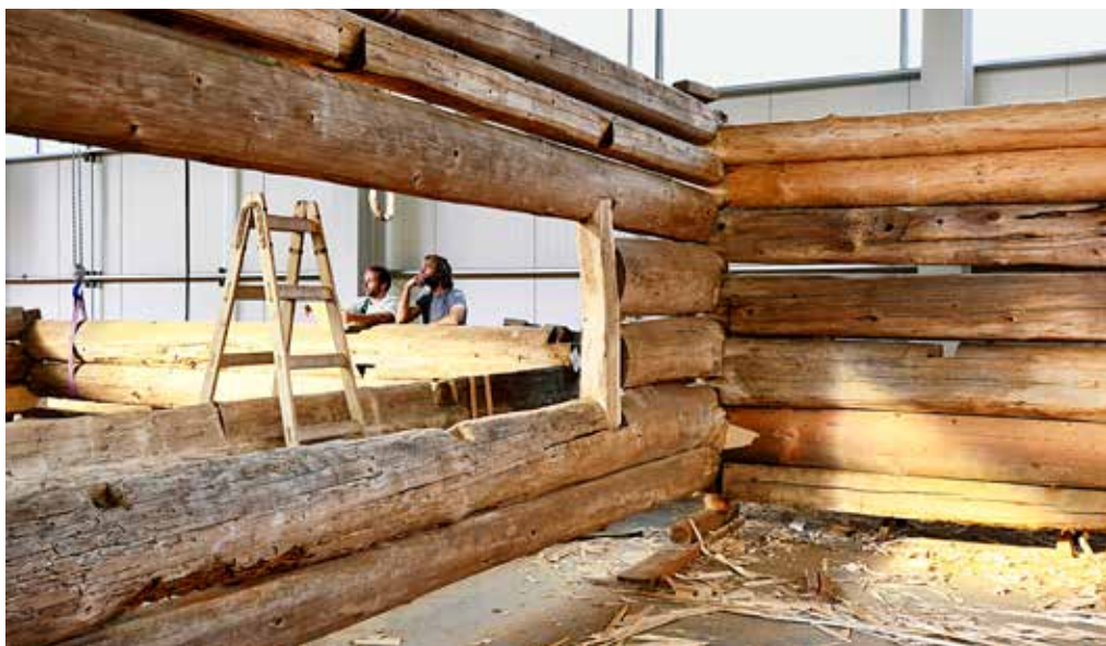
Obr. 6. Práce na transferované stodole ze Skaličky v depozitární hale Valašského muzea v přírodě, tesařskou obnovu prováděli Jiří Pokorný a David Stejskal, převážná část dochovaných trámů stodoly pochází dle výsledků dendrochronologického datování ze dvou hlavních stavebních etap – z druhé poloviny 16. a z druhé poloviny 18. století, foto: autor, 2021
