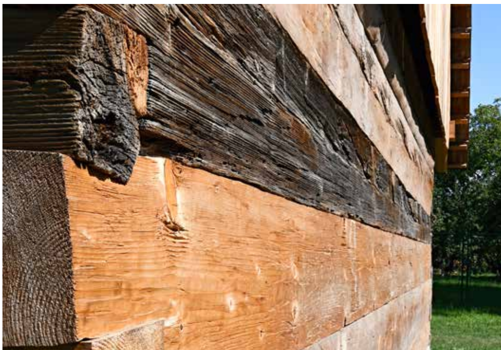
Obr. 8. Hanácké muzeum v Příkazích, transferovaná stodola ze Skaličky, detail roubené stěny, na povrchu starého trámu pozorujeme stopy opracování a stáří, na novém trámu stopy opracování, dokládající řádné tesařské řemeslo, foto: autor, 2022
