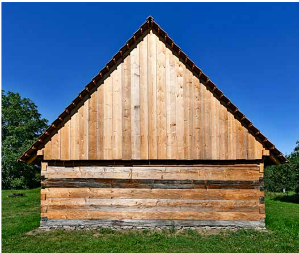
Obr. 7. Hanácké muzeum v Příkazích, transferovaná stodola ze Skaličky, pohled na štítovou stěnu s rozsáhlejší nutnou náhradou trámů roubení a s novým bedněným štítem, foto: autor, 2022
