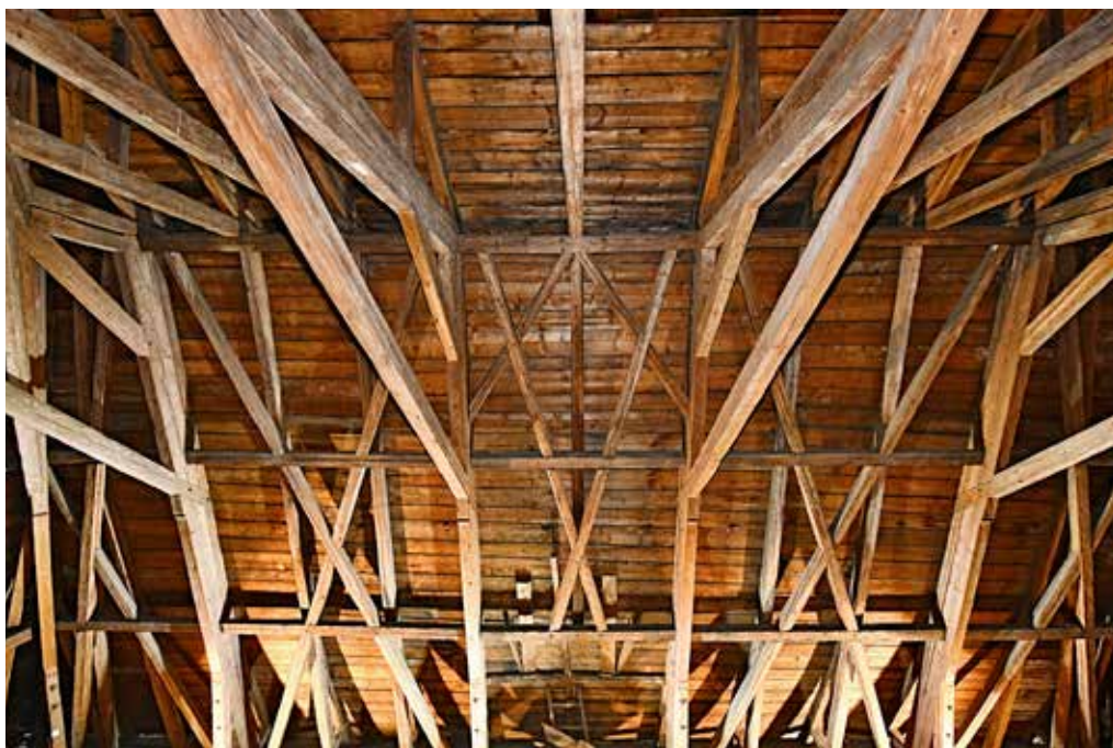
Obr. 3. Fulnek, kostel Nejsvětější Trojice, polovina 18. století, pohled na část krovové konstrukce – zavětrování ležaté stolice, foto: autor, 2019
