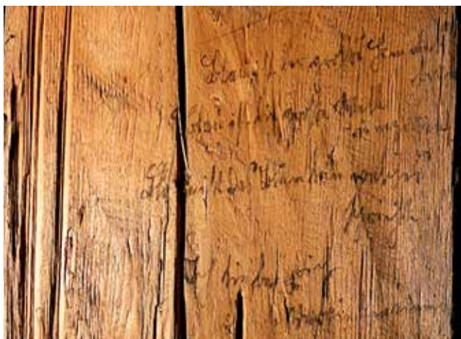
Obr. 5. Fulnek, kostel Nejsvětější Trojice, nápis asi z roku 1913 na dodatečně vložené patní vzpěře krovu, na níž lze pozorovat také stopy po opracování, foto: autor, 2019 Přepis:
