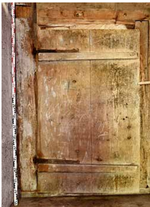
Obr. 2. Morávka, hlavní obydlí pasekářské usedlosti čp. 269 (dnes č. ev. 468), svlakové dveře se stopami užívání, vedoucí z podsínku do síně trojdílného domu, foto: autor, 2022
