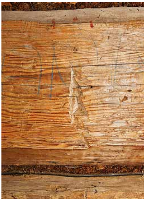
Obr. 1. Morávka, hlavní obydlí pasekářské usedlosti čp. 269 (dnes č. ev. 468), stopa po vrubování na trámu roubené konstrukce, foto: autor, 2022
