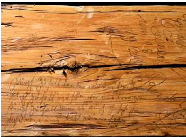
Obr. 4. Fulnek, kostel Nejsvětější Trojice, nápis asi z roku 1913 na dodatečně vložené patní vzpěře krovu, na níž lze pozorovat také stopy po opracování, foto: autor, 2019 Přepis:
