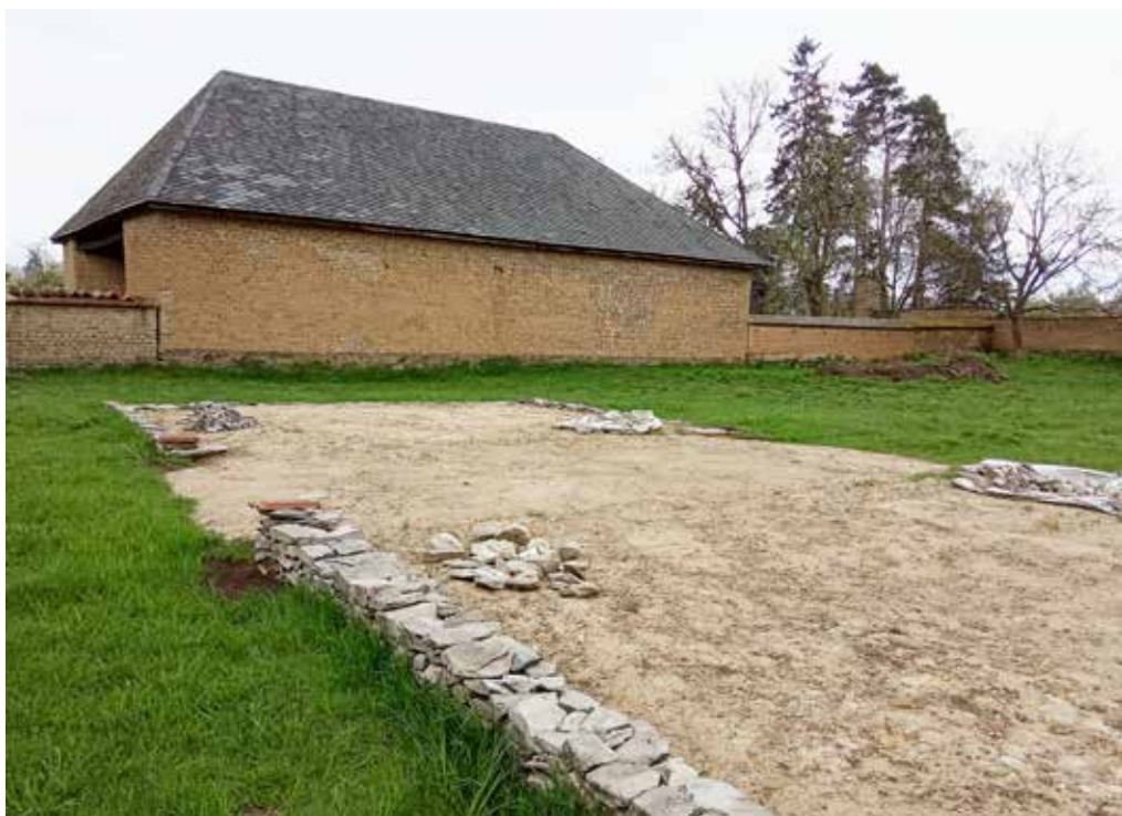
Obr. 4. Založení stavby v Příkazích, foto: Radek Bryol, 2021
