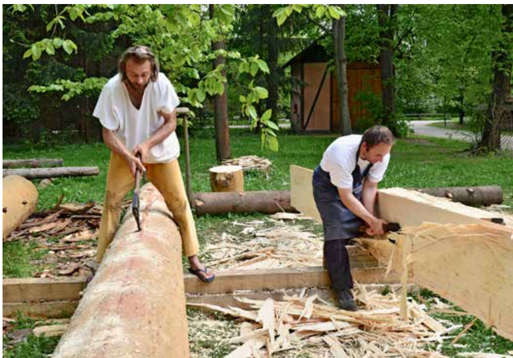
Obr. 2. Technologický experiment podélného štípání kmenů, foto: Radek Bryol, 2017
