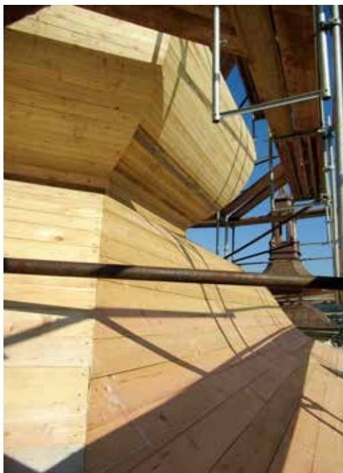
Obr. 6. Kostel Zvěstování Panny Marie ve Šternberku, detail nového bednění krovu, foto: autor, 2021
