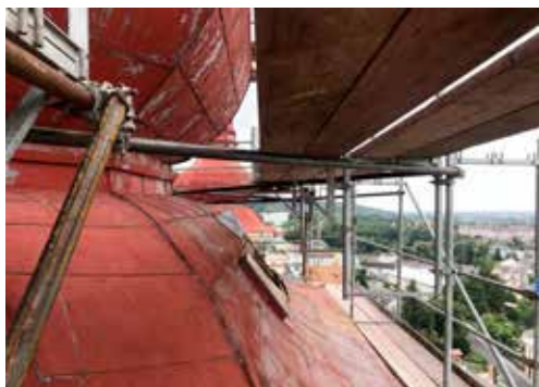
Obr. 1. Kostel Zvěstování Panny Marie ve Šternberku, detail původní plechové krytiny věže, foto: autor, 2020
