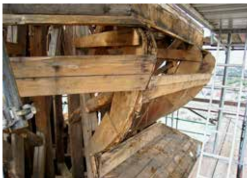
Obr. 2. Kostel Zvěstování Panny Marie ve Šternberku, detail původního krovu po odstranění plechové krytiny věže, foto: autor, 2020
