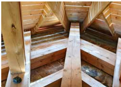
Obr. 4. Kostel Zvěstování Panny Marie ve Šternberku, detail ukotvení konstrukce nového krovu ke zdivu věže, foto: Zuzana Vyjídáková, 2021
