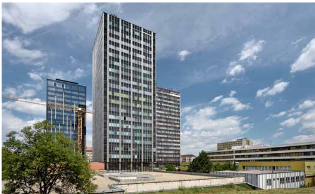
Obr. 7. Soubor tří výškových administrativních budov na Šumavské se záběry dvou původních, dnes již neexistujících, fasád, foto: Roman Polášek
