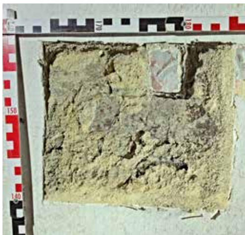
Obr. 16. Fara v Hořepníku, ložnice, fragment předbarokní povrchové úpravy na severozápadní stěně k hale, pohled od jihovýchodu, foto: autor, 2021
