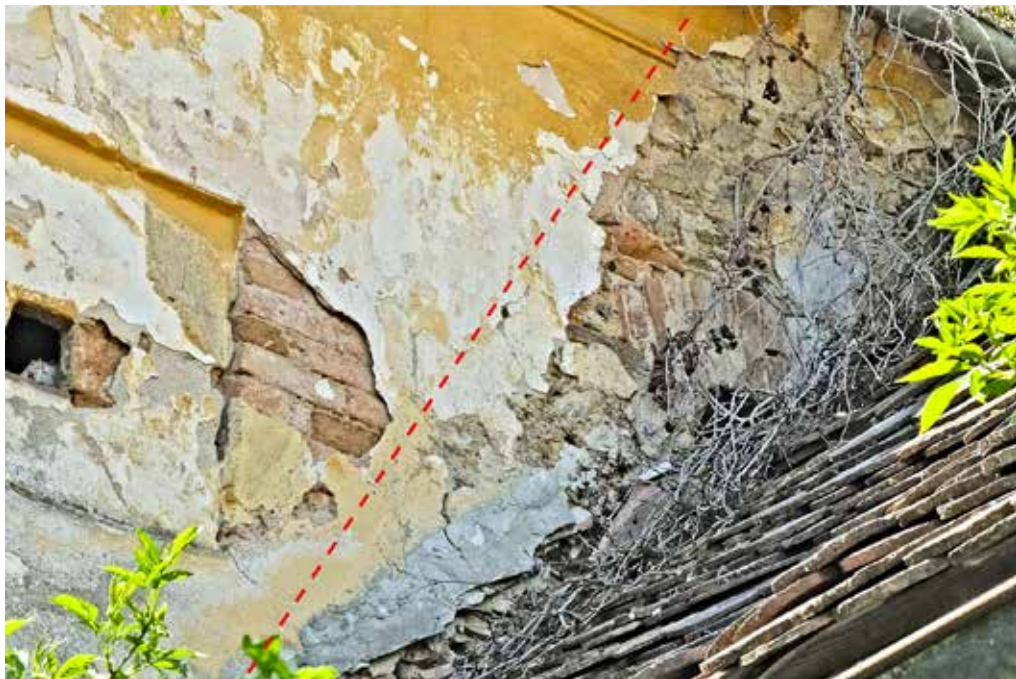
Obr. 14. Fara v Hořepníku, severovýchodní fasáda v úrovni patra, nad střechou hospodářské přístavby u druhého zazděného okénka od západu, zakres pomyslné linie hranice případného předbarokního štítu, pohled od severovýchodu, foto a zakres: autor, 2021
