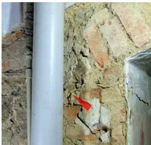
Obr. 15. Fara v Hořepníku, kuchyň/kotelna, fragment zazděného otvoru v podobě koutu špalety s nátěry na jihovýchodní zdi blízko průchodu do haly, pohled od západu, foto: autor, 2021
