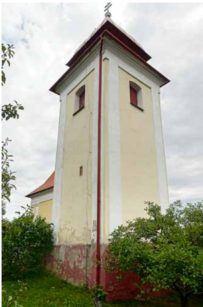
Obr. 4. Prosetín, areál kostela sv. Markéty, samostatně stojící zvonice, pohled na západní (vlevo) a jižní průčelí, foto: autor, červenec 2021
