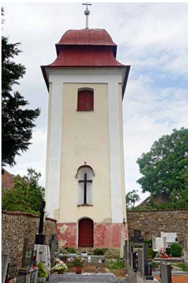
Obr. 3. Prosetín, areál kostela sv. Markéty, samostatně stojící zvonice, pohled od východu, foto: autor, červenec 2021
