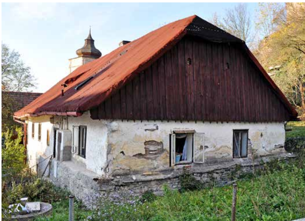
Obr. 4. Snímek objektu od jihovýchodu v době zahájení průzkumu. Roubení je dosud „v kožichu“ a otevřená okna vedou do světnice na pravé straně dispozice, foto: autor, 2018
