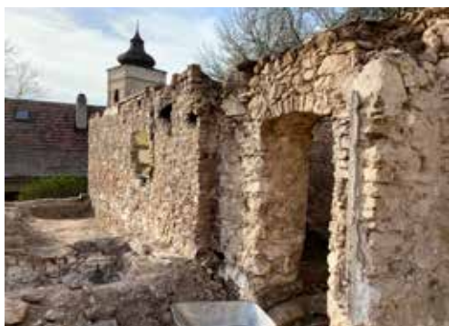
Obr. 11. Pohled na severní stěnu přední komory s odhalenou nikou, vzniklou zazděním starších dveří. Vpravo je vstup do černé kuchyně, zde již bez klenby, foto: Stanislav Plešák, 2021
