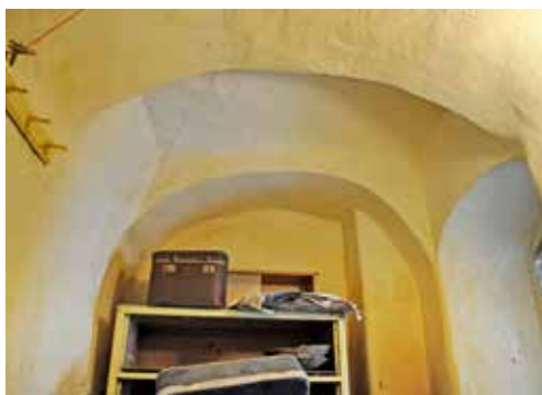
Obr. 12. Pohled do černé kuchyně směrem ke světnici, vpravo nahoře je patrné podklenuté ústí dymníku, foto: autor, 2018
