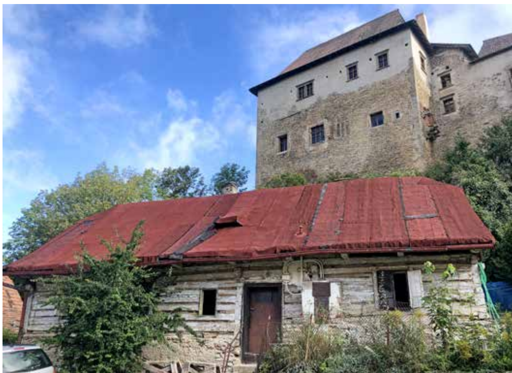
Obr. 5. Jižní strana domu po otlučení omítek a odkrytí roubení. Za hřebenem vykukuje dvojice tahových komínů a okénko vlevo od vstupu do síně je větší než na historickém snímku, foto: Stanislav Plešák, 2020
