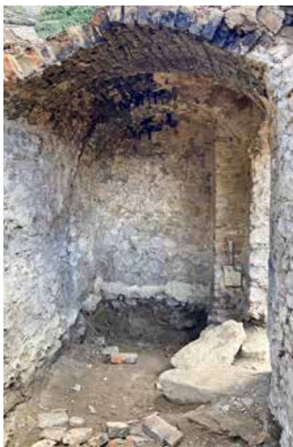
↑ Obr. 14. Zadní část černé kuchyně: detail dodatečného průřezu klenby pro vstup na půdu, foto: autor, 2020
