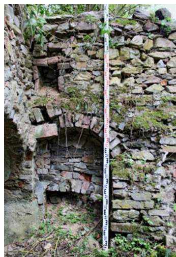
Obr. 30. Pasovary, bývalá tvrz, vnitřní líc východní obvodové stěny staré kuchyně (E) s příkladacími otvory topenišť, foto: Veronika Babická, 2022
