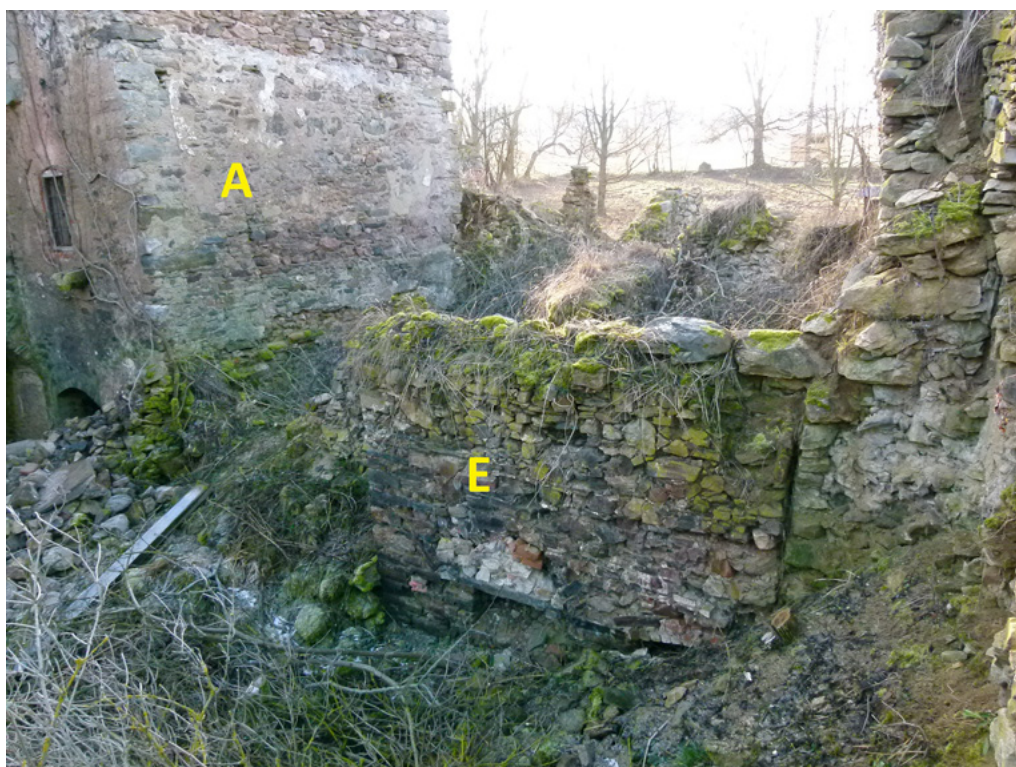
Obr. 31. Pasovary, bývalá tvrz, východní stěna staré černé kuchyně (E), v dolní části zdi jsou patrné příklady (vlevo kamenný, vpravo cihelný) příkladacích otvorů, zcela vpravo patrná přízdivka štítové stěny kuchyně posazená na ochoz gotické hradby, přízdivka je svislou spárou oddělená od zdiva budovy F z 15. století (ve spodní části snad předprseň hradby), foto: Veronika Babická, 2022
