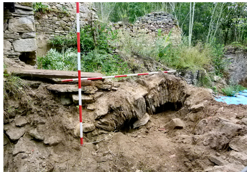
Obr. 25. Pasovary, bývalá tvrz, přízemí gotického paláce (B), částečně zhroutilý záklenek vstupu ze síně B2.2 do černé kuchyně / příkladacího prostoru B2.3 nalezený v destrukci, foto: Veronika Babická, 2019
