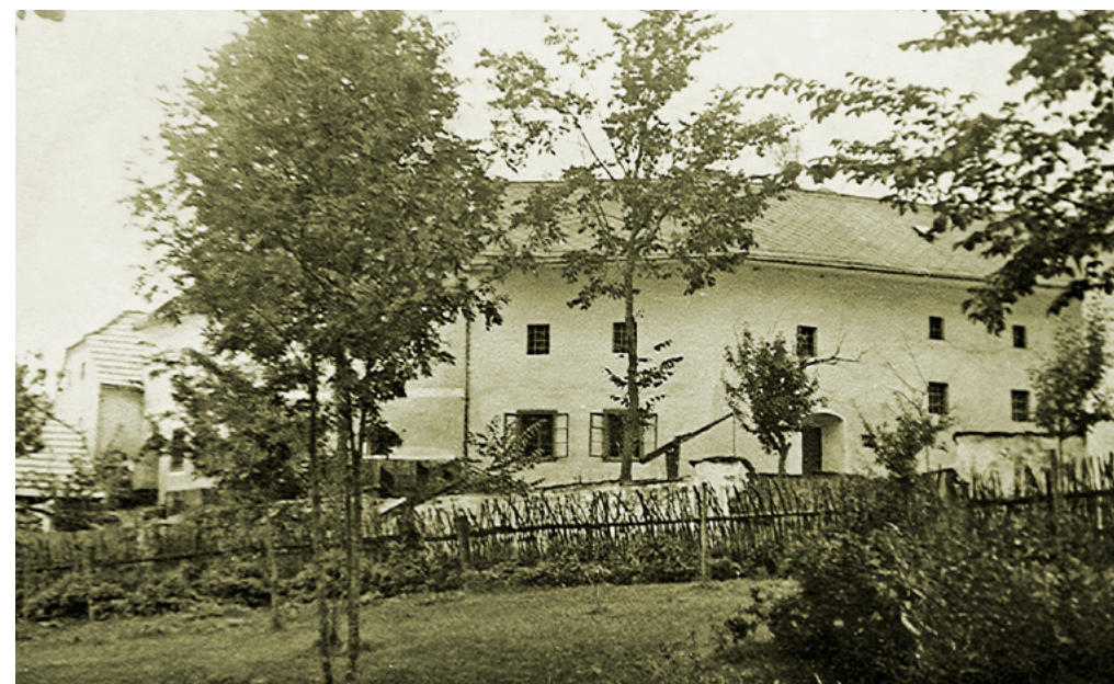
Obr. 27. Pasovary, bývalá tvrz, tzv. renesanční palác, pohled od severu, před polovinou 20. století, foto: obec Světlík, b. d.
