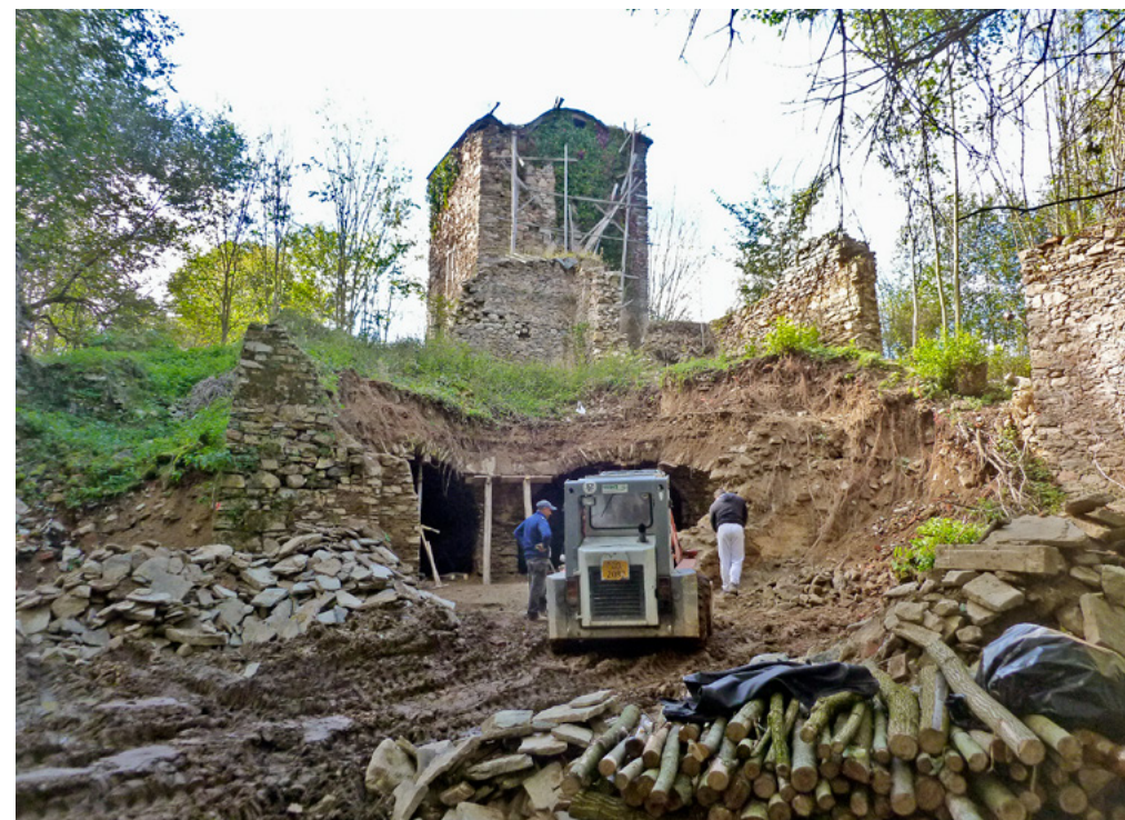
Obr. 7. Pasovary, bývalá tvrz, pohled od východu, sanace staticky narušených sklepů gotického paláce (B), foto: Radek Liška, 2018
