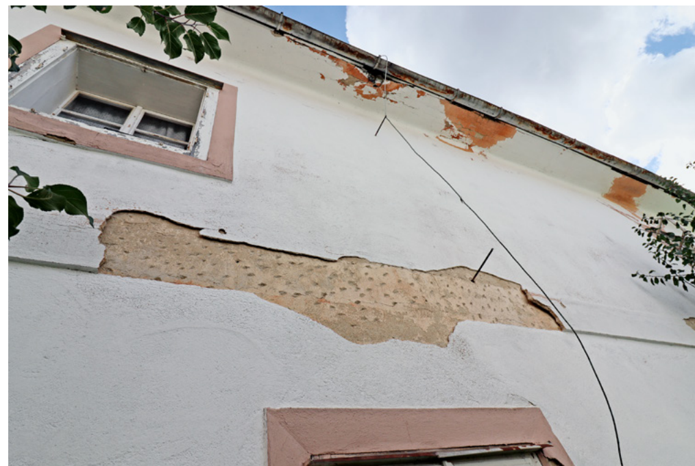
Obr. 12. Loučovice, západní průčelí domu fišmistra, detail starší pekované omítky pod plastickou kordovou římsou, foto: autorka, 2023
