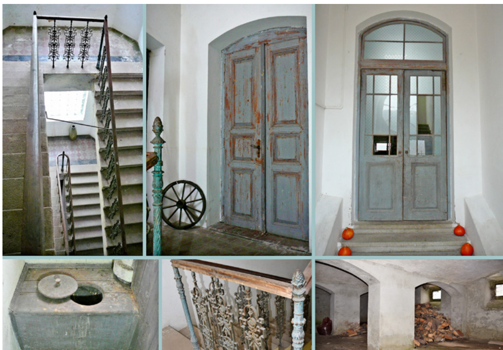
Obr. 3. Hůrky, školní budova, centrální schodiště, dveře do kabinetu v patře, kyvné dveře za hlavním vstupem, suchý záchod s poklopem, zábradlí u schodiště a část sklepení, foto: autor, 2022.
