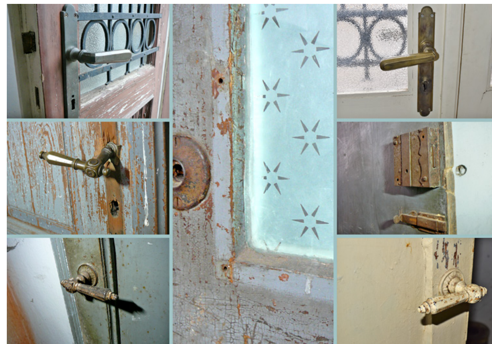
Obr. 2. Hůrký, školní budova, detaily dveří a klik, foto: autor, 2022
