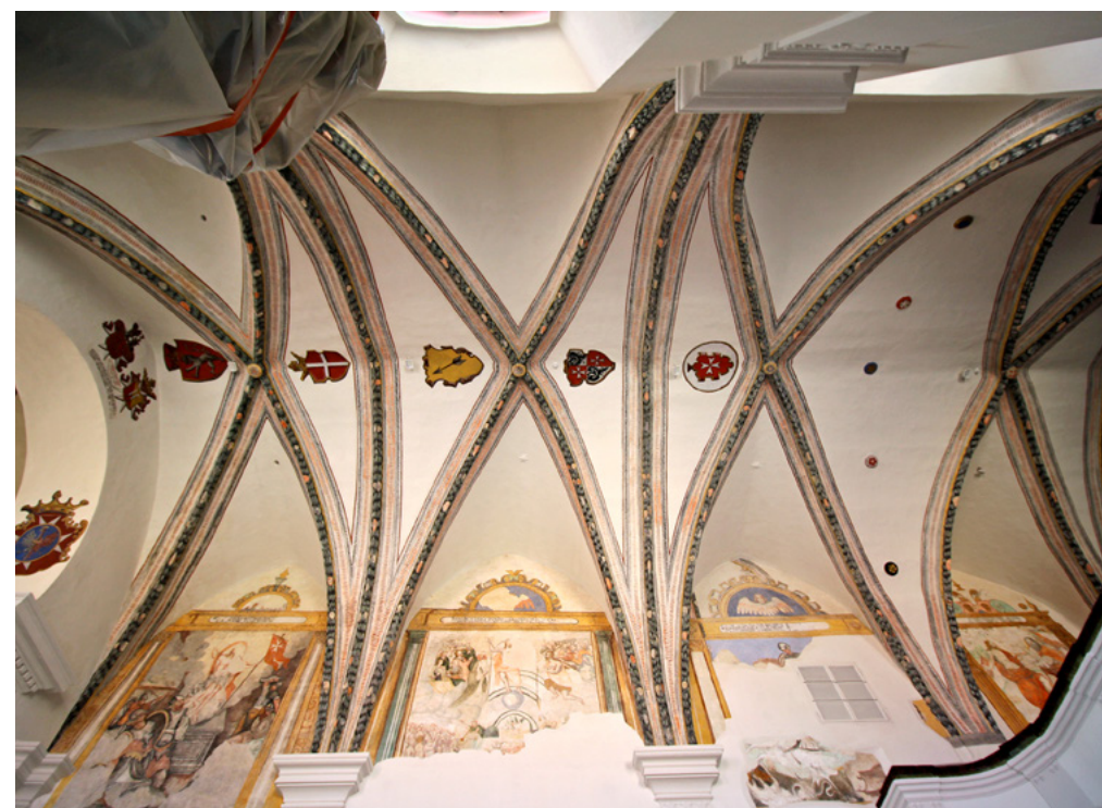
Obr. 1. Strakonice, kostel sv. Prokopa, klenba a jižní stěna lodi, stav při dokončování restaurátorského zásahu, foto: Roman Lavička, 2022
