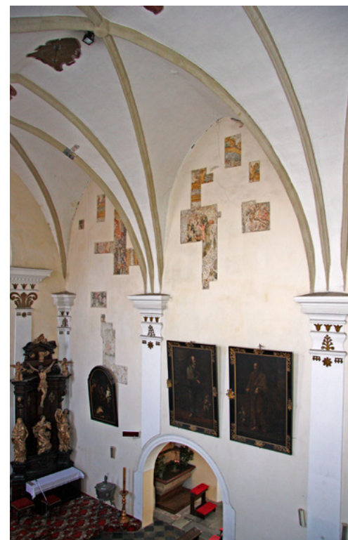
Obr. 3. Strakonice, kostel sv. Prokopa, klenba a jižní stěna lodi, stav po provedení sondážního restaurátorského průzkumu, foto: Roman Lavička, 2011
