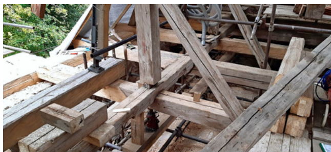
↑ Obr. 3. Slavonice, kostel Božího Těla a sv. Ducha, tesařská oprava krovu, foto: Michaela Trojáková, 2019
