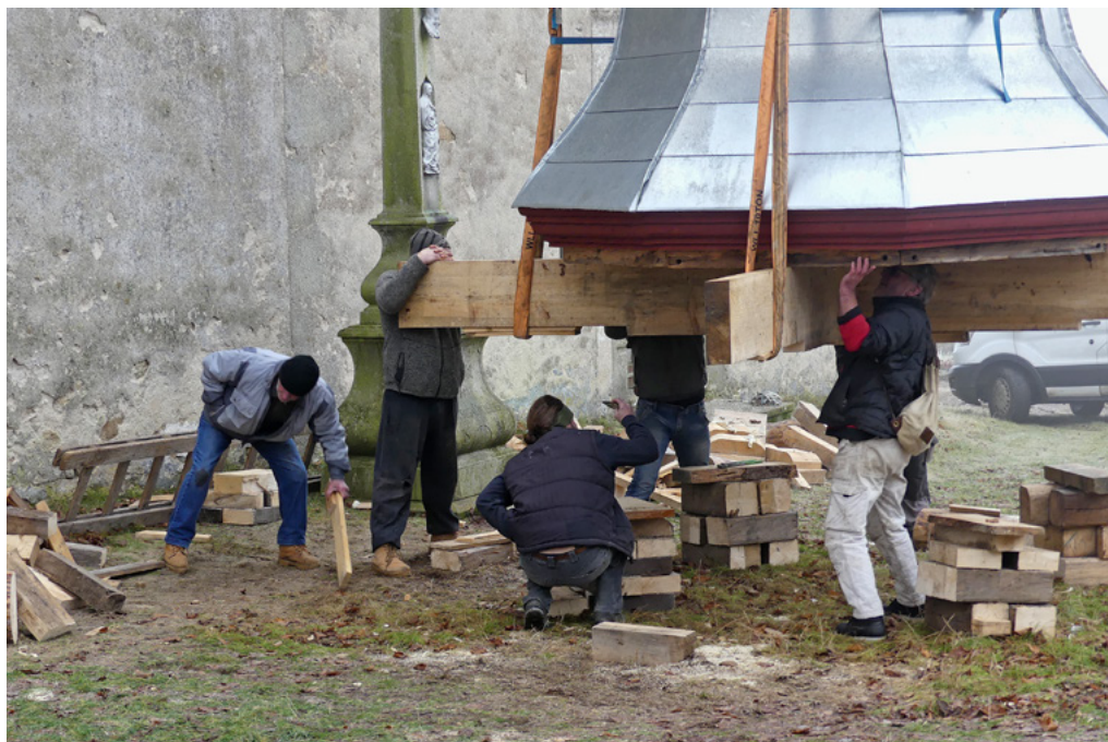
Obr. 1. Slavonice, kostel Božího Těla a sv. Ducha, osazování sanktusníku do původní polohy, foto: Petr Chadim, 2020
