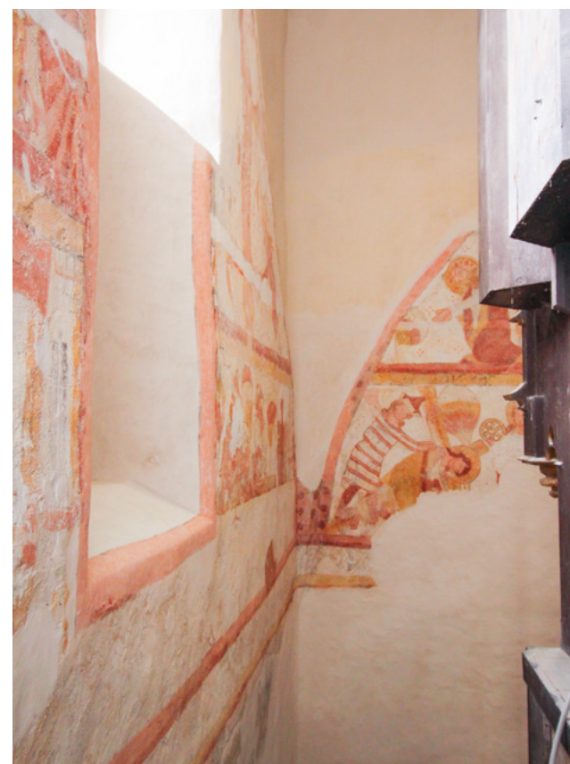
↑ Obr. 3. Strýčice, kostel sv. Petra a Pavla, presbytář, detail restaurátorské sondy do souvrství nátěrů a omítek, foto: Roman Lavička, 2018
