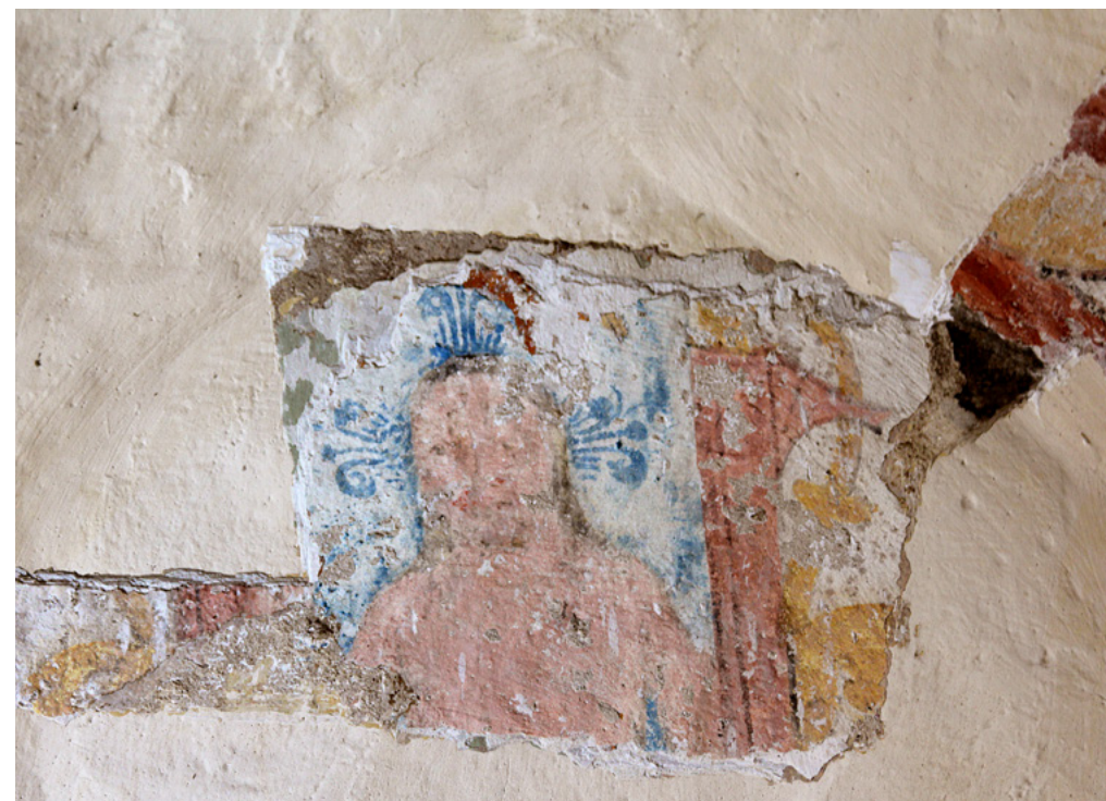
↑ Obr. 3. Strýčice, kostel sv. Petra a Pavla, presbytář, detail restaurátorské sondy do souvrství nátěrů a omítek, foto: Roman Lavička, 2018
