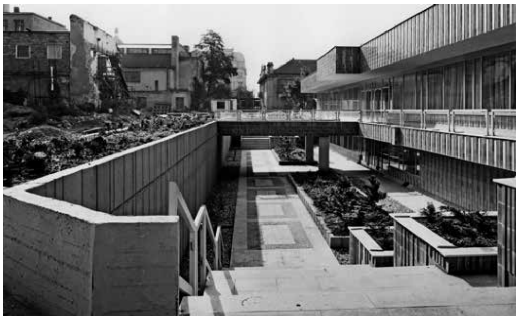
Obr. 15. Zapuštěné atrium, foto: fotoarchiv NPÚ, ÚOP v Pardubicích, Milan Křištof, 1983
