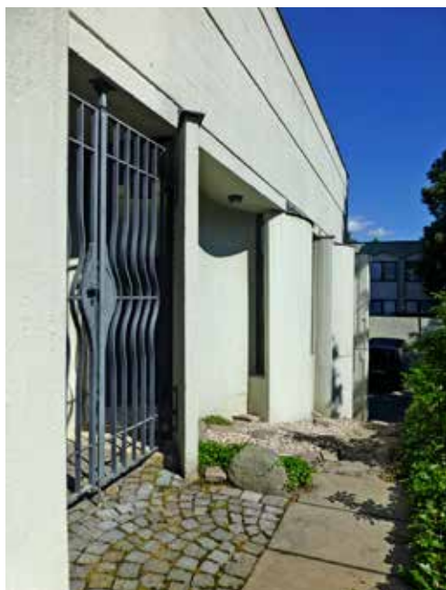
Obr. 4. Segmentová východní fasáda – exteriér, foto: Jitka Svobodová, 2020
