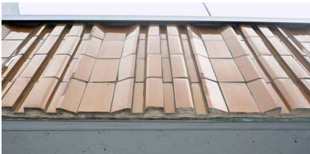
Obr. 17. Tvarovaný keramický obklad, exteriér, foto: Alžběta Bílková, 2020
