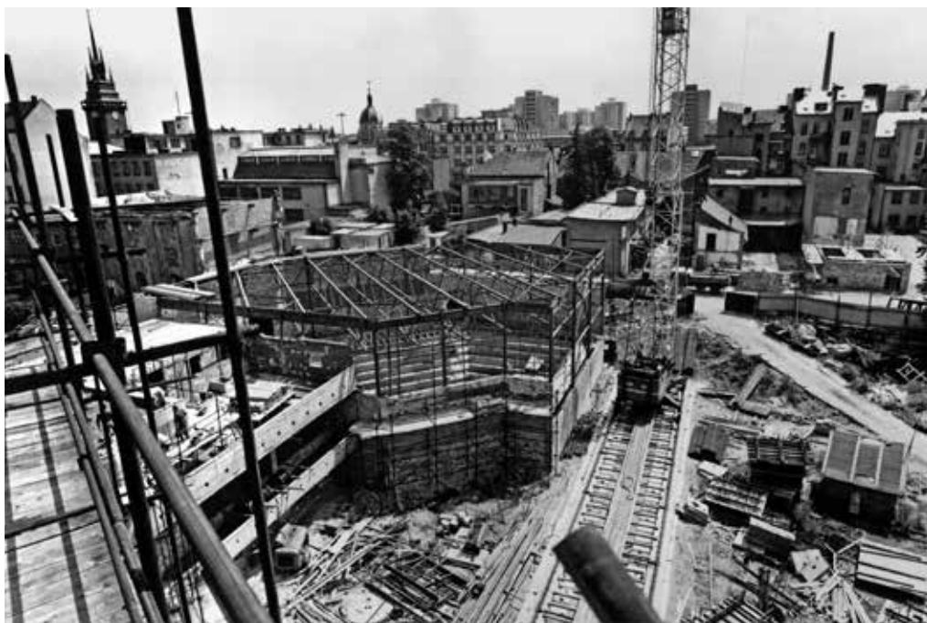
Obr. 16. Výstavba a konstrukce hlavního sálu, foto: fotoarchiv NPÚ, ÚOP v Pardubicích, Milan Křištof, 1983
