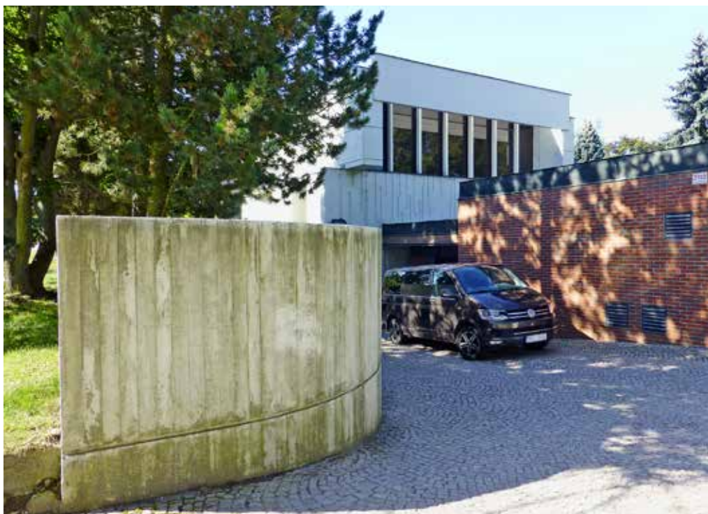
Obr. 11. Betonová stěna při hlavním vjezdu, foto: Jitka Svobodová, 2020
