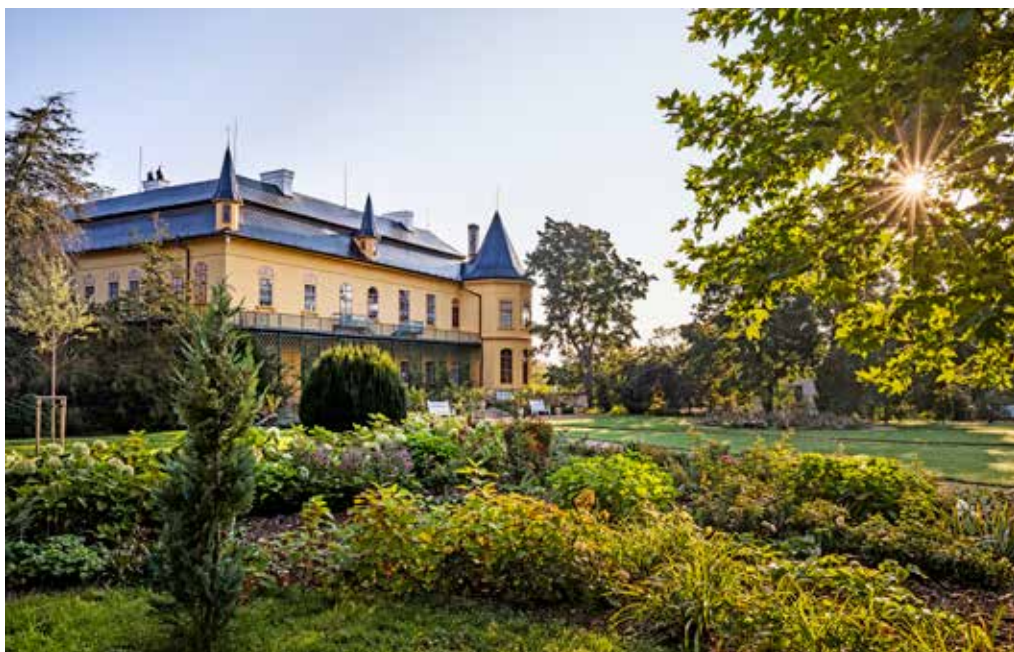
Obr. 13. Jižní průčelí zámku Slatiňany, 2021, zdroj: NPÚ, SZ Slatiňany
