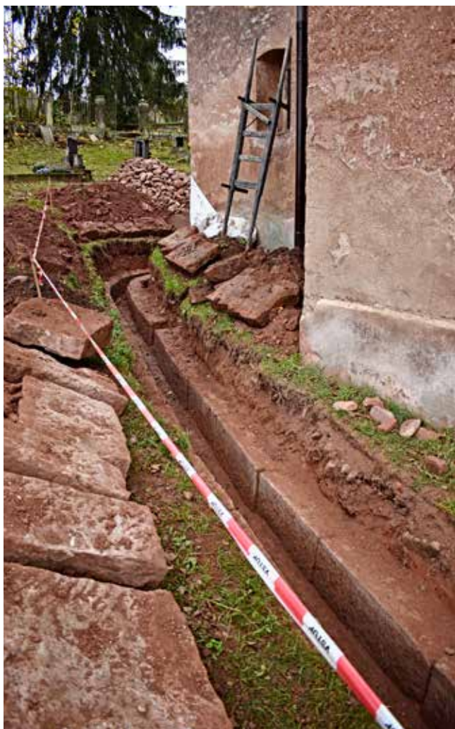
Obr. 3. Odkrytý odvodňovací kanál u kostela sv. Jakuba v Dolní Olešnici, foto: Vladimíra Paterová, 2022
