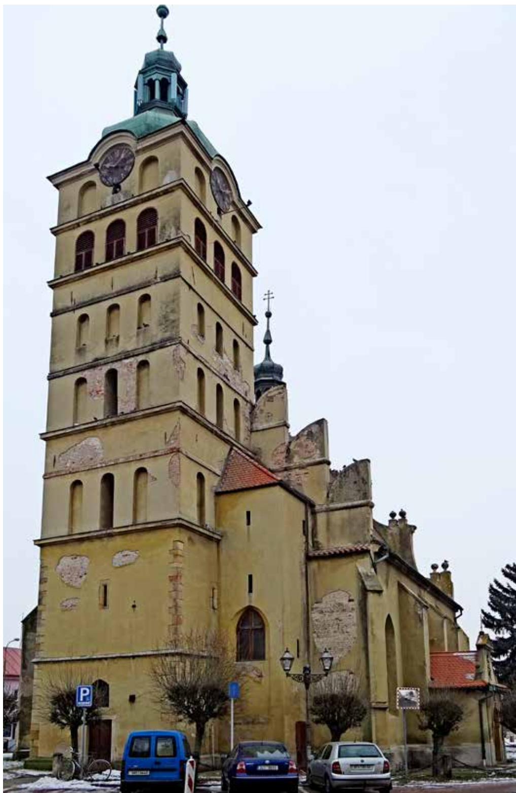
Obr. 1. Kostel sv. Voršily v Chlumci nad Cidlinou, celkový pohled na věž před obnovou, foto: Zdeněk Čermák, 2017
