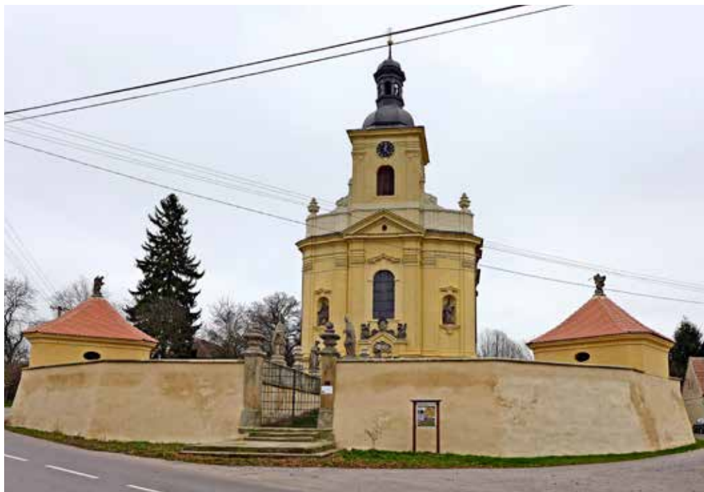
Obr. 1. Kostel sv. Václava po opravě průčelí, kaplí a ohradní zdi, foto: Petra Machová, 2014
