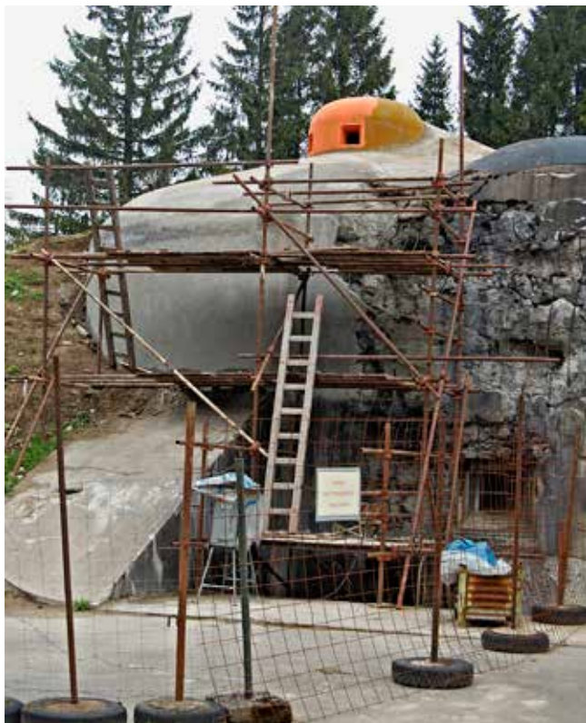
Obr. 3. Dělostřelecký srub R-S 79 „Na Mýtině“, replika zvonu a rekonstrukce zdiva levého křídla, foto: Jan Tluchoř, 2022
