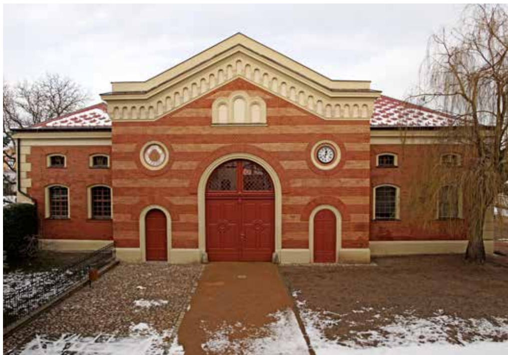
Obr. 1. Hlavní průčelí budovy po obnově, foto: Jan Krátký, 2022
