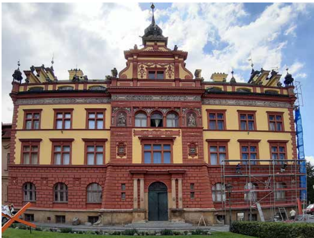
Obr. 1. Obnova fasády budovy Regionálního muzea v Chrudimi, foto: Martin Jičínský, 2022
