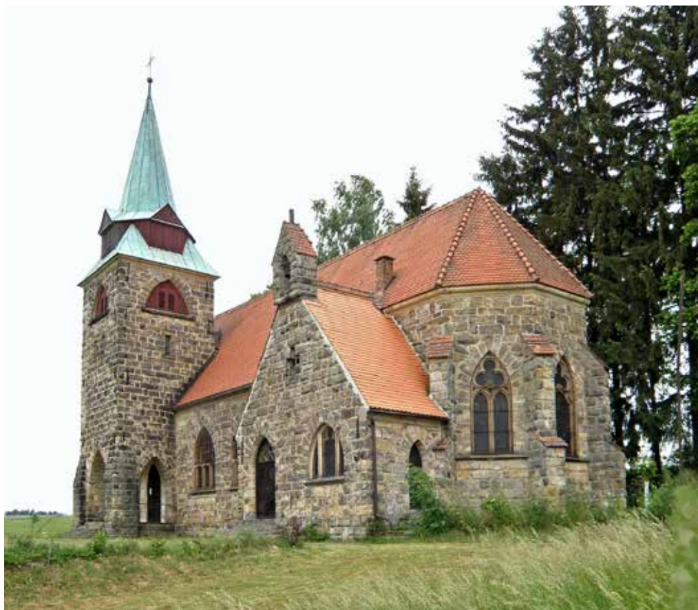
Obr. 6. Kostel Božského Srdce Páně v Borovničce, foto: Viktor Blažek, 2021
