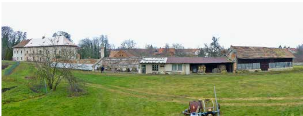
Obr. 2. Panoramatický snímek panské zahrady od glorietu. Zleva budova býv. kuželníku (faktorie), malý skleník (za ním zeď staršího skleníku s komínem), ananasovna s komínem, stavby v prostoru nedochovaného velkého palmového skleníku a vpravo fíkovna, foto: Jitka Svobodová, 2021
