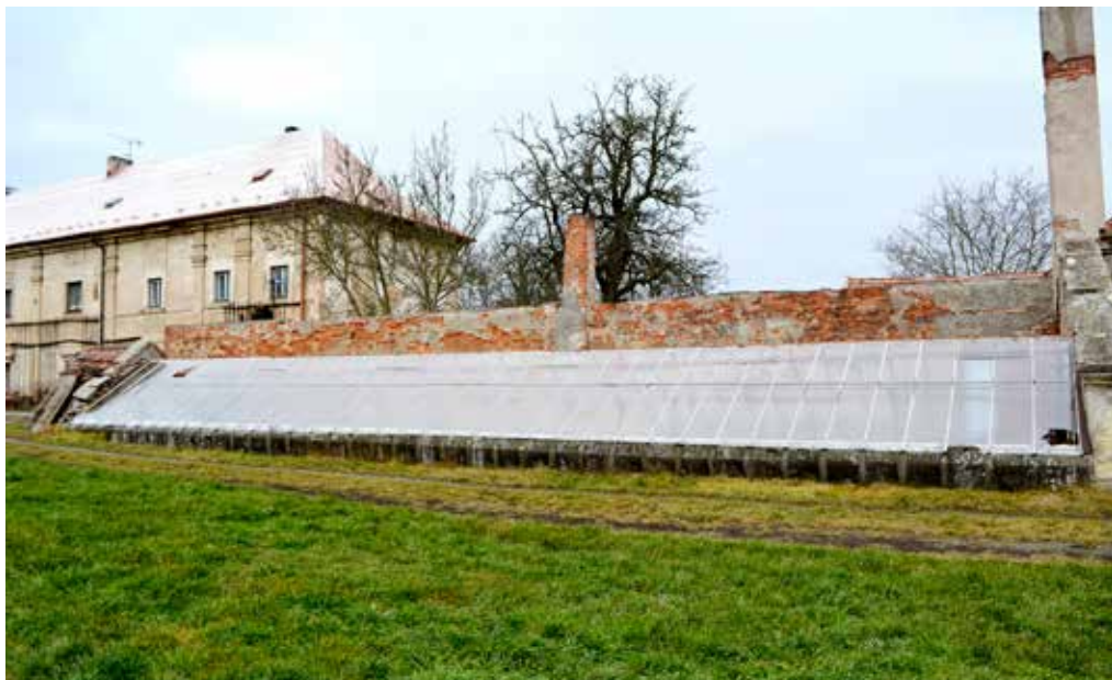
Obr. 3. Celkový pohled, nalevo budova bývalého kuželníku a za skleníkem cihlová zeď starší oranžerie s původním komínem, foto: Milan Křištof, 2021
