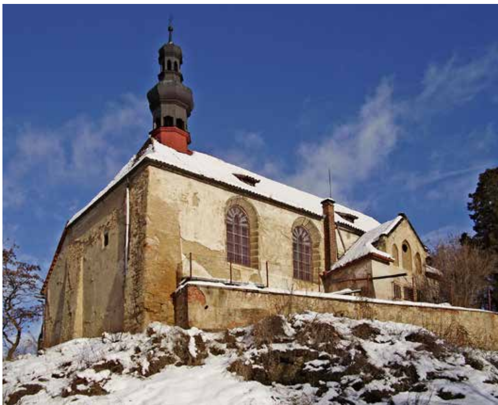
Obr. 1. Plzeň, kostel sv. Mikuláše od jihozápadu, na západní straně patrná původní úroveň terénu, jež byla kolem ostatních stran kostela po vybudování ohradní zdi postupně výrazně navýšena, zdroj: Fotoarchiv NPÚ, ÚOP v Plzni, foto: Hynek Šlais, 2009
