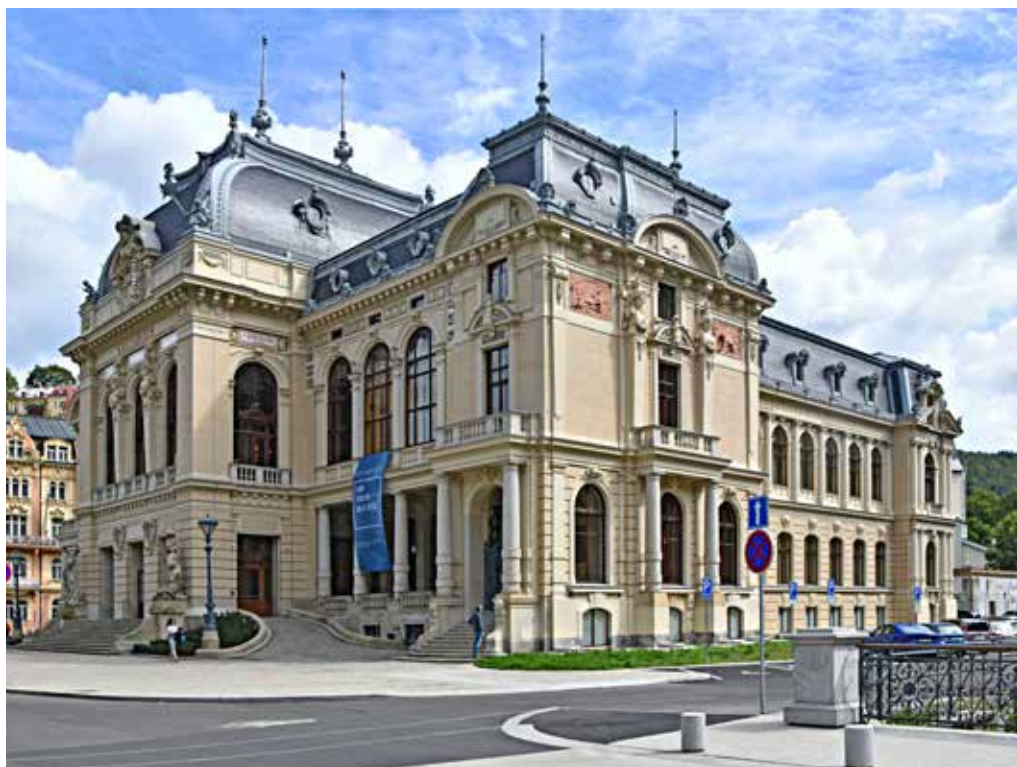
Obr. 3. Karlovy Vary, Mariánskolázeňská čp. 306, pohled od západu, zdroj: NPÚ, ÚOP v Lokti, foto: Lubomír Zeman, 2023
