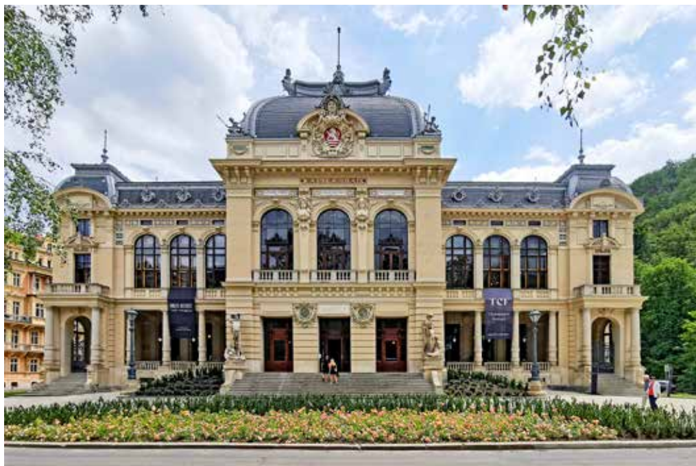
Obr. 1. Karlovy Vary, Mariánskolázeňská čp. 306, pohled od severozápadu, zdroj: NPÚ, ÚOP v Lokti, foto: Lubomír Zeman, 2023
