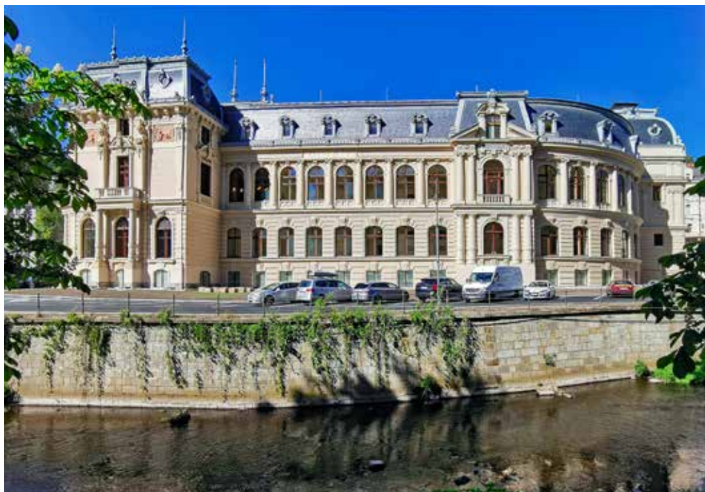
Obr. 4. Karlovy Vary, Mariánskolázeňská čp. 306, pohled od jihozápadu, zdroj: NPÚ, ÚOP v Lokti, foto: Lubomír Zeman, 2023
