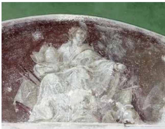
Obr. 4. Klášter premonstrátů v Teplice, opatský byt, opatova pracovna, odkrytá malba zobrazující triumf duchovní vlády nad světskou v průběhu restaurování, zdroj: NPÚ, ÚOP v Lokti, foto: autorka, 2015
