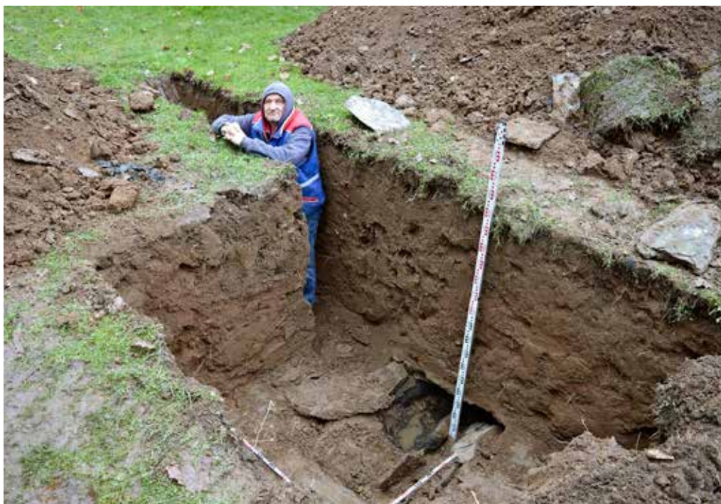
Obr. 2. Manětín, zámecký dvůr, sonda s historickým kanálem na jejím dně, zdroj: NPÚ, ÚOP v Plzni, foto: Marcela Waldmannová, 2022
