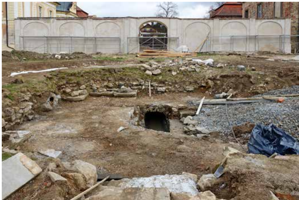
Obr. 3. Nebílovky, zámecká zahrada, nález pozůstatků barokní kašny s podzemní štolou, zdroj: NPÚ, ÚOP v Plzni, foto: Linda Foster, 2022
