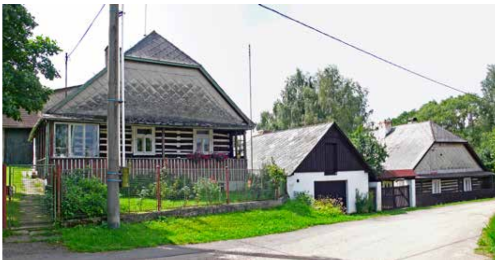
Obr. 5. Strašice, místní část Dvůr, zleva chalupy čp. 138 a 139, zdroj: NPÚ, ÚOP v Plzni, foto: Karel Foud, 2008
